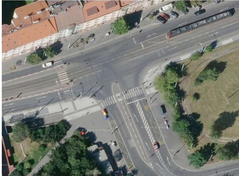
obr. A16 - Křižovatka č. 16: Letecký pohled, zdroj [13]
