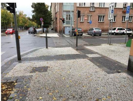
Obr. D64 – Hmatové úpravy, JZ nároží
