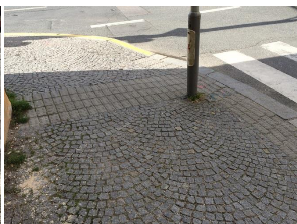
Obr. D49 – U Královské louky, JV nároží, detail hmatových úprav
