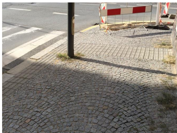
Obr. D47 – U Královské louky, SV nároží, detail hmatových úprav
