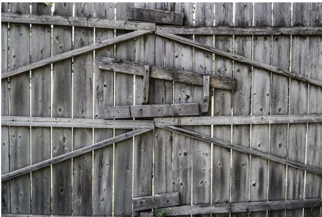
Obr.3: Poškození povrchu dřeva povětrnostními vlivy
