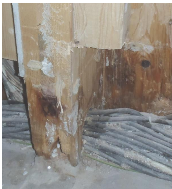
Obr.21: Obnažená destruovaná část dřevěné nosné konstrukce vlivem vlhkosti
