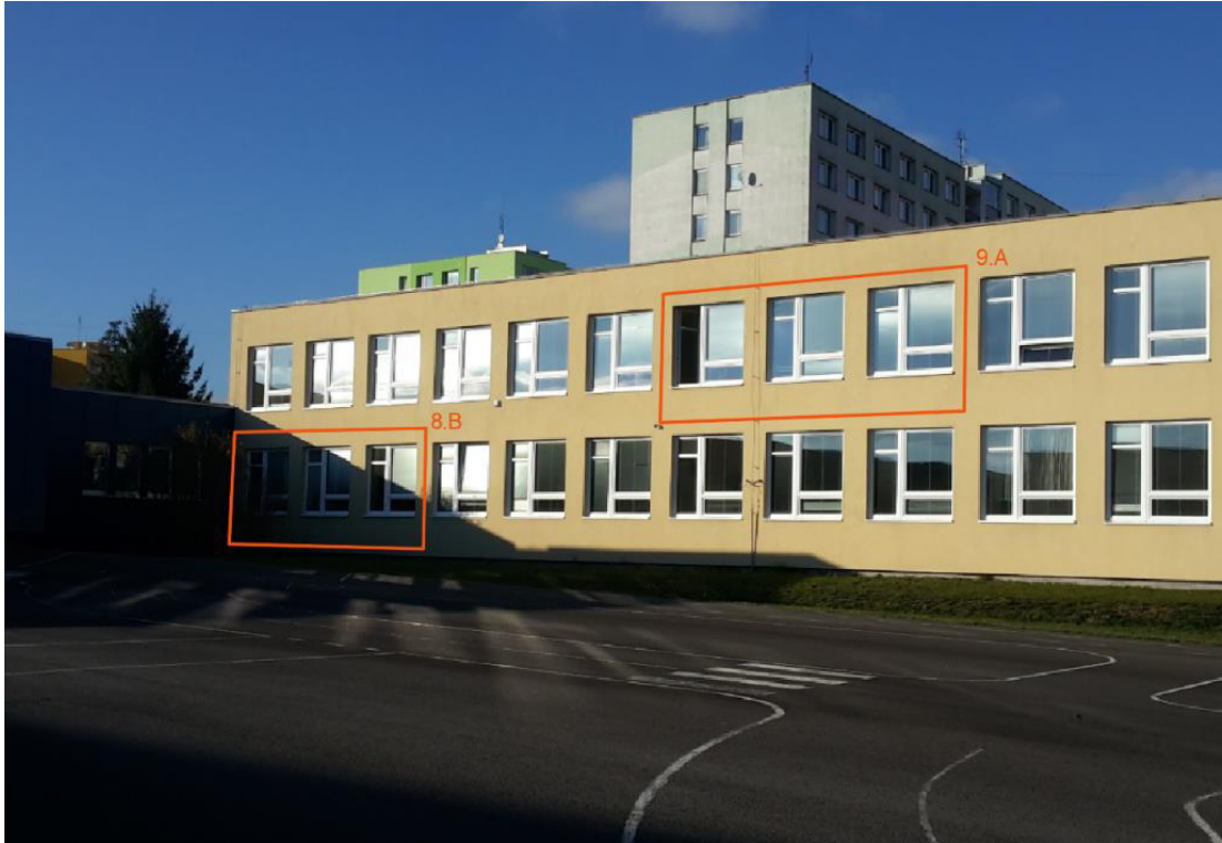
Obrázek 21: Pohled na fasádu s označením vybraných učeben
