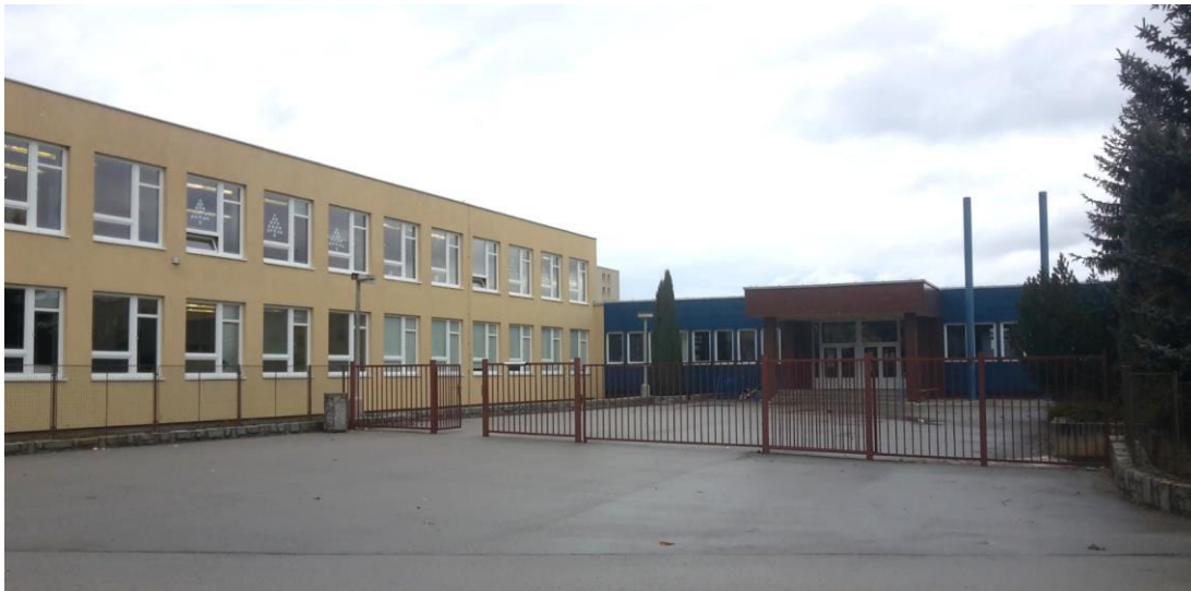
Obrázek 18: Fotografie vstupu 5. ZŠ
