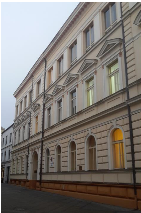
Obrázek 6: Fotografie vstupu 1. ZŠ
