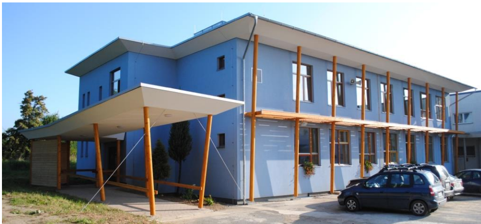
Obr. 13 Původní stav školy z roku 1968 a stav po rekonstrukci z roku 2009 (tzb-info, 2011)
