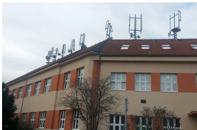
Obr. 14 Základní škola Praha - Dubeč
