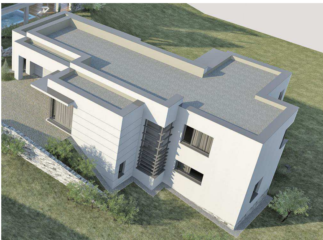
Obr. 4 Pohled na střechu
