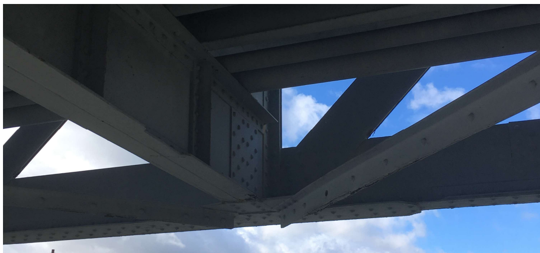
Obrázek 57 Oslabení výřezem 20. příčníku pole č.2
