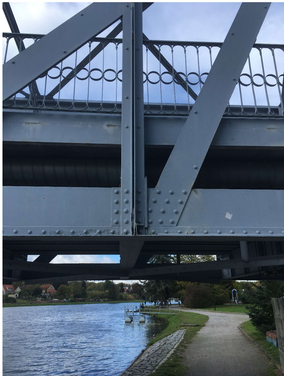
Obrázek 59 Spojení svislíce s dolním pásem
