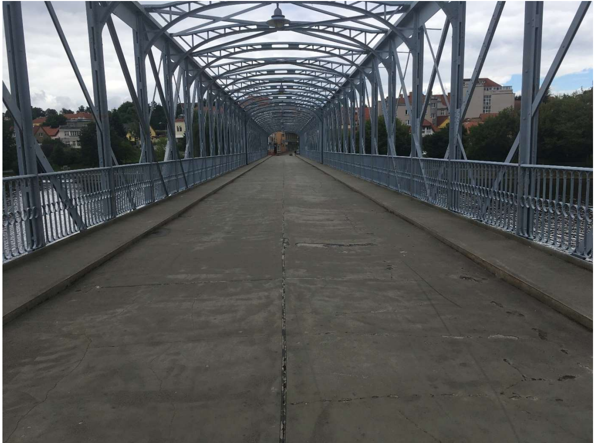
Obrázek 10 Deska mostovky s živičným povrchem (Týn nad Vltavou, Česká republika)
