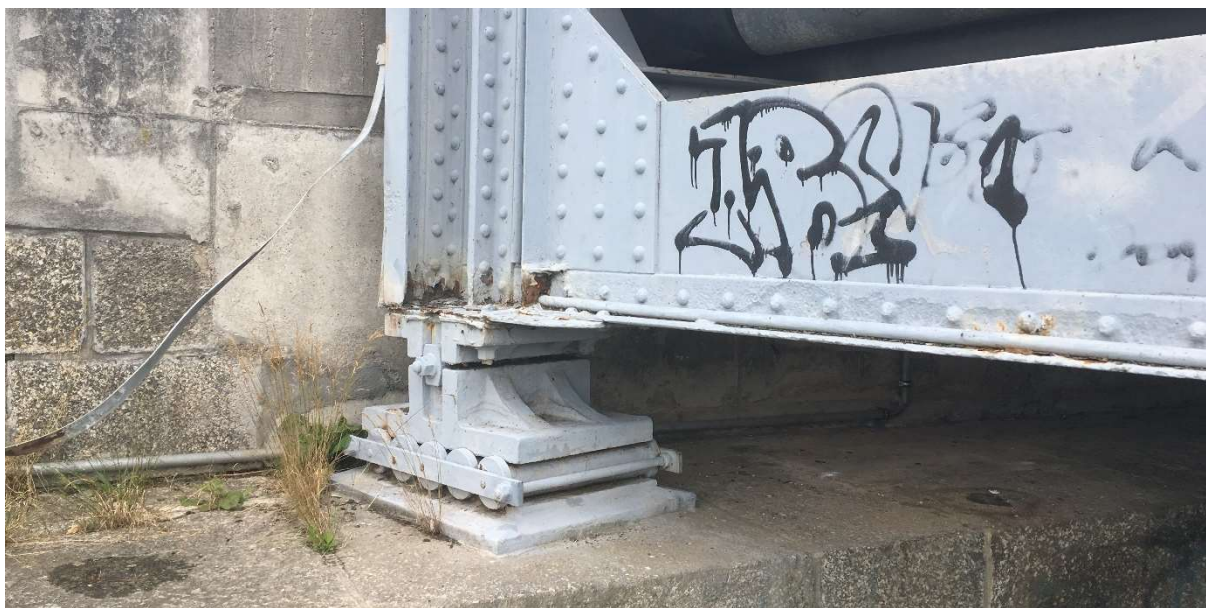
Obrázek 16 Pětiválečkové pohyblivé ložisko (Týn nad Vltavou, Česká republika)
