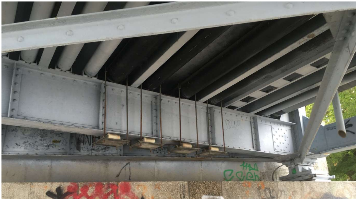
Obrázek 8 Příčník na opěře O3 (Týn nad Vltavou, Česká republika)
