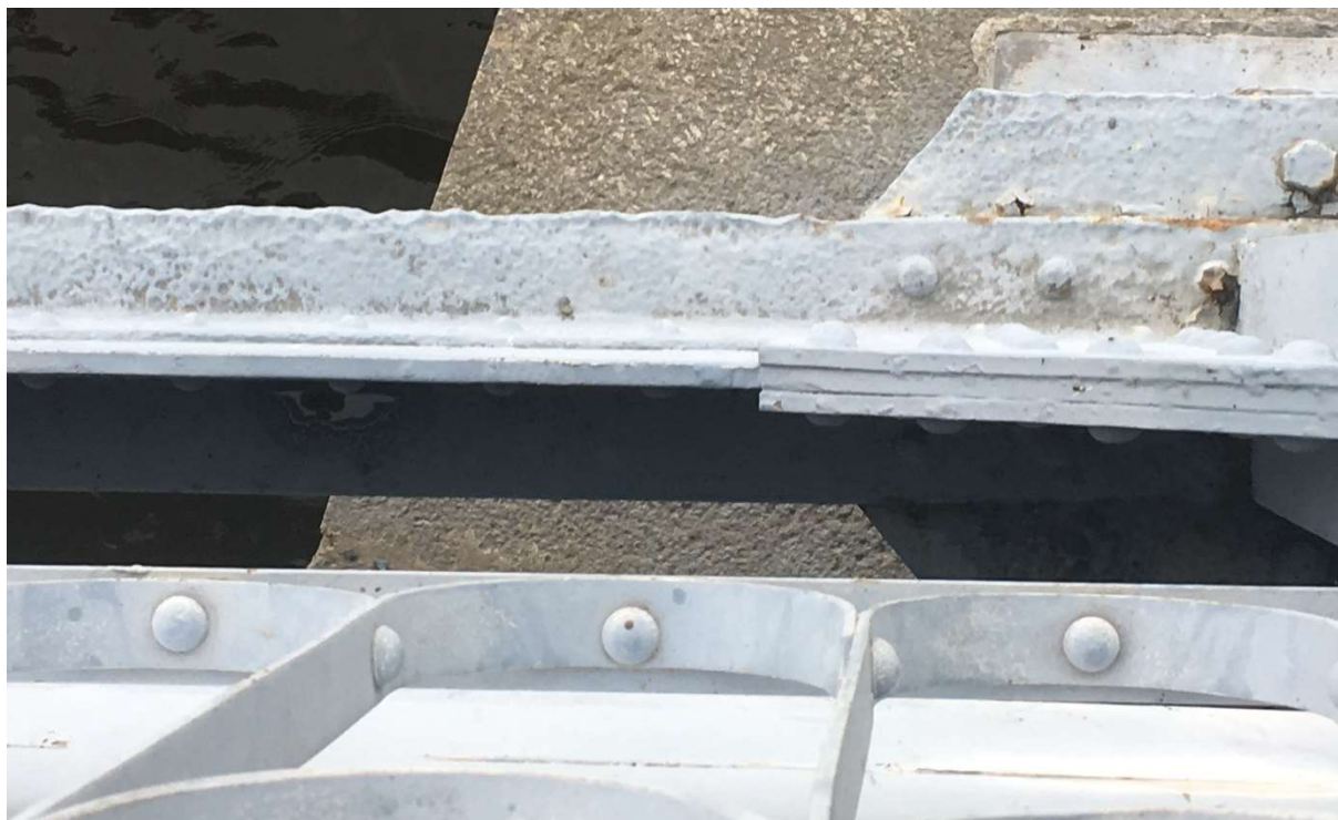
Obrázek 21 Usazování vody na pásnici dolního pásu (Týn nad Vltavou, Česká republika)
