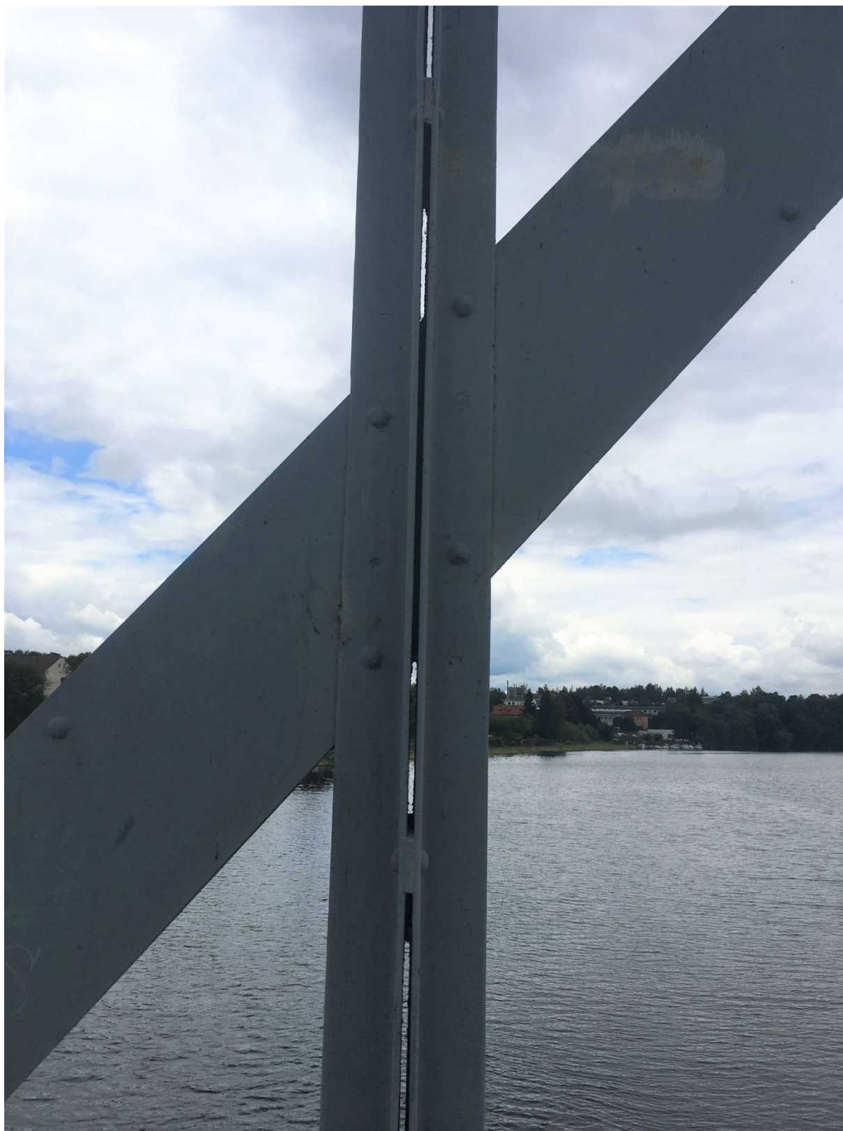
Obrázek 6 Svislice povodní strany 1.pole (Týn nad Vltavou, Česká republika)
