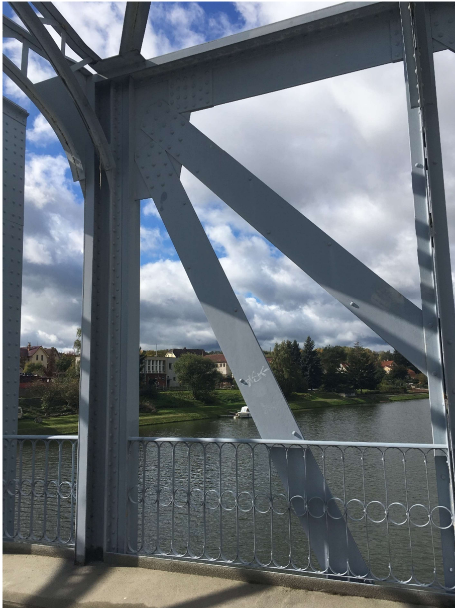
Obrázek 7 Diagonála hlavního příhradového nosníku (Týn nad Vltavou, Česká republika)
