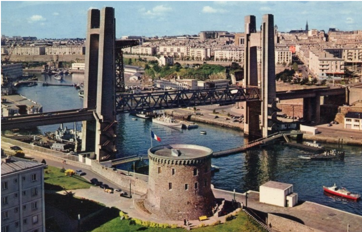
Obrázek 3 pont de la Recouvrance (Brest, Francie)
