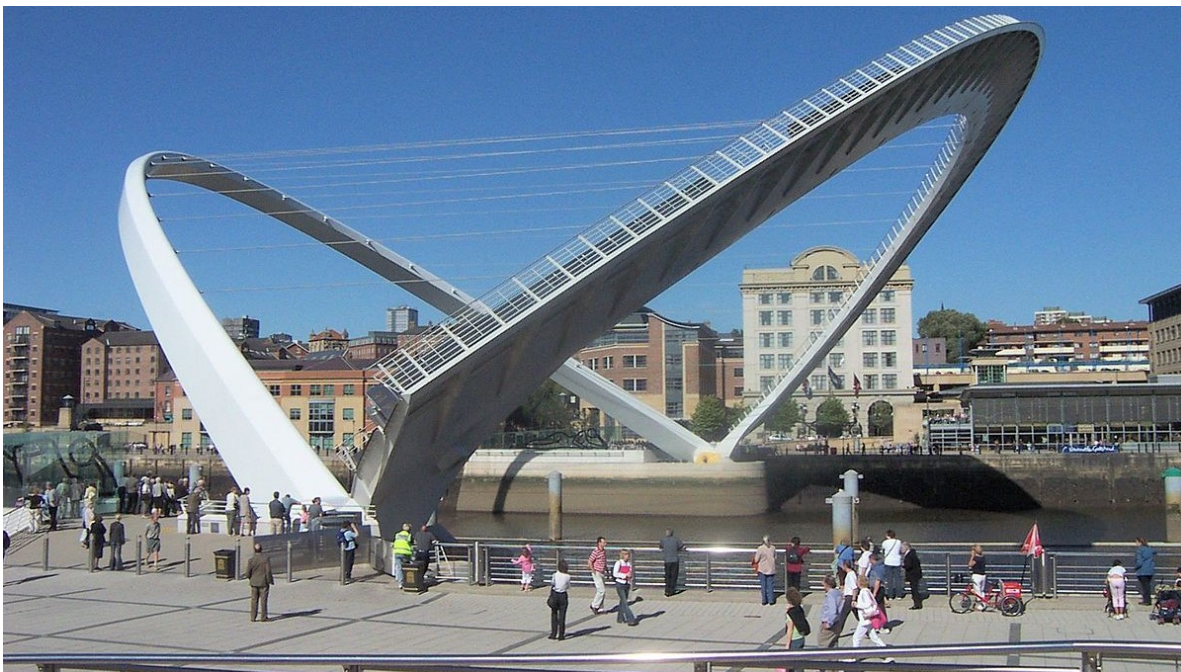
Obrázek 5 Millenium bridge (Newcastle, Anglie)
