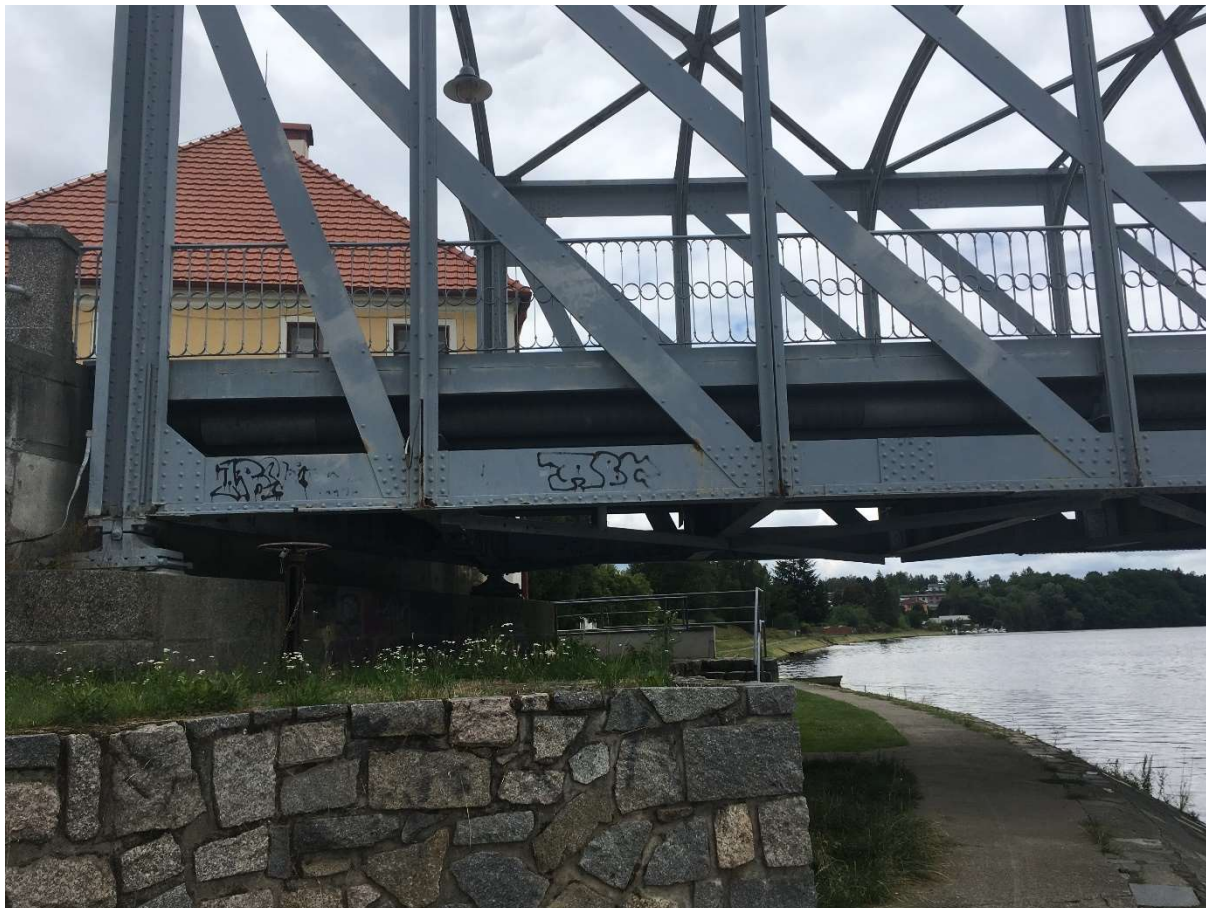
Obrázek 13 Opěra O1, levý břeh (Týn nad Vltavou, Česká republika)
