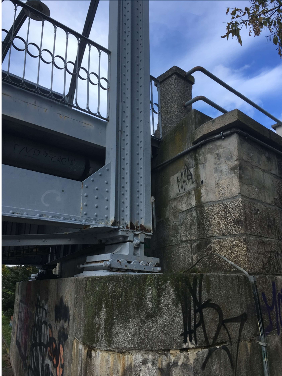
Obrázek 5 uložení krajní svislice na opěře O3 (Týn nad Vltavou, Česká republika)
