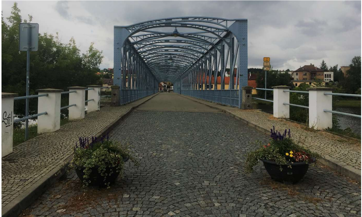
Obrázek 19 Pohled na most z Mostecké ulice (Týn nad Vltavou, Česká republika)
