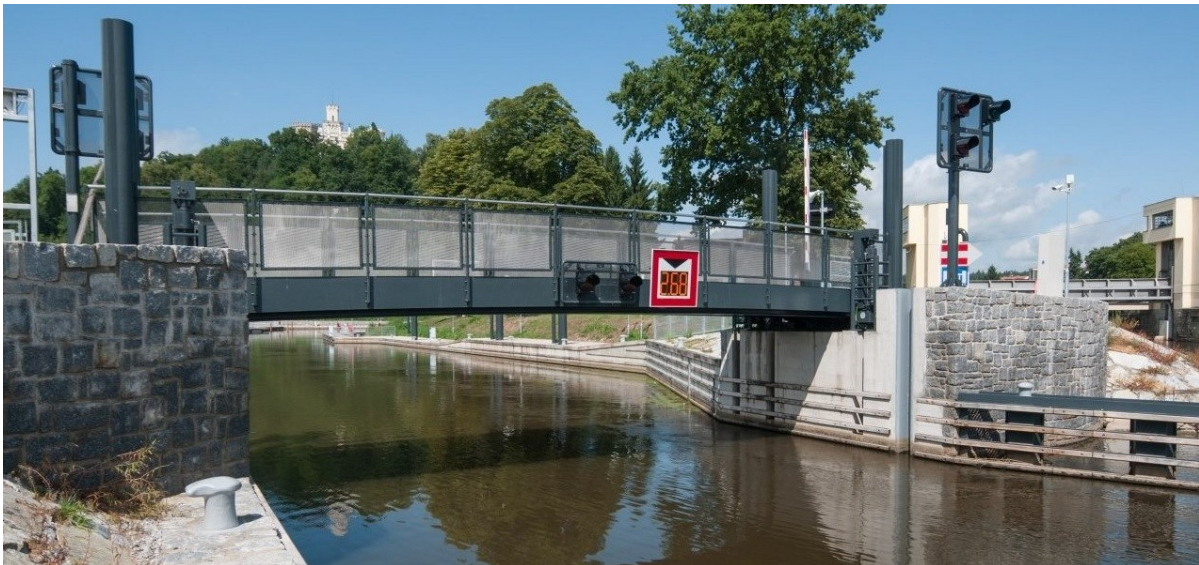
Obrázek 24 Světelná signalizace zdvihací lávky (Hluboká nad Vltavou, Česká republika)
