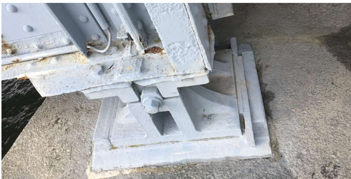
Obrázek 17 Stolicové pevné ložisko (Týn nad Vltavou, Česká republika)
