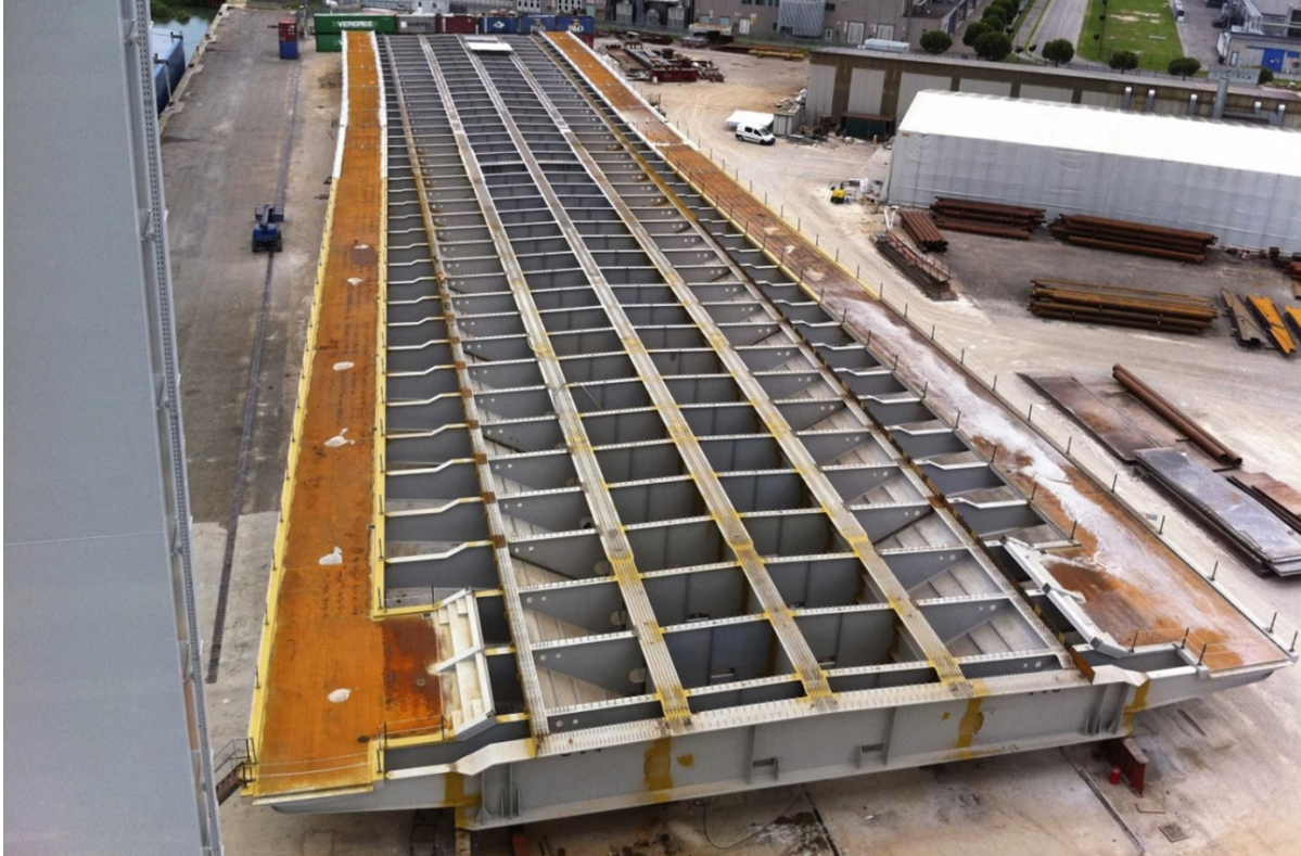
Obrázek 16 Přeprava ocelové části komorového nosníku, pont Jacques Chaban-Delmas (Bordeaux, Francie)
