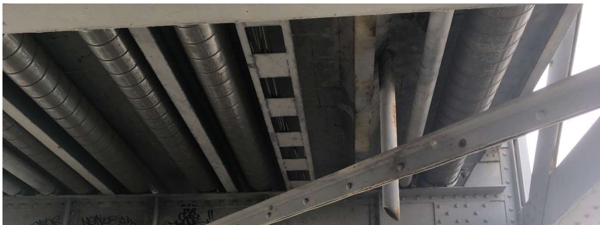
Obrázek 9 Podélníky a vedení inženýrských sítí (Týn nad Vltavou, Česká republika)
