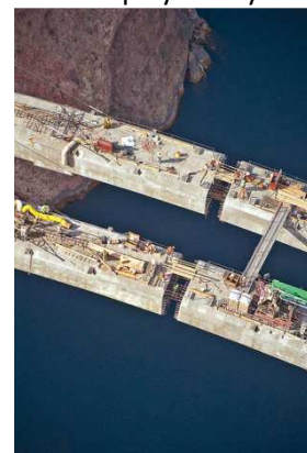
Obr. 2.41 Oblouk ve vrcholu těsně před spojením [24]
