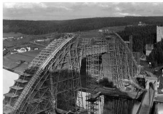
Obr. 2.43 Postup výstavby mostu na pevné skruži [26]
