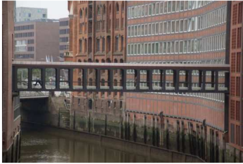
Obr. 3.5 Vpravo příklad Vierendeelova nosníku [27], vlevo schéma spojení mostovky a oblouku
