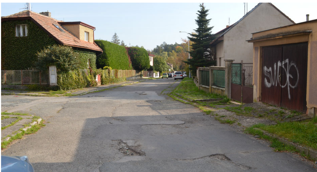
Obr. 30: Ulice Labská – Rekonstrukce rok 2018
