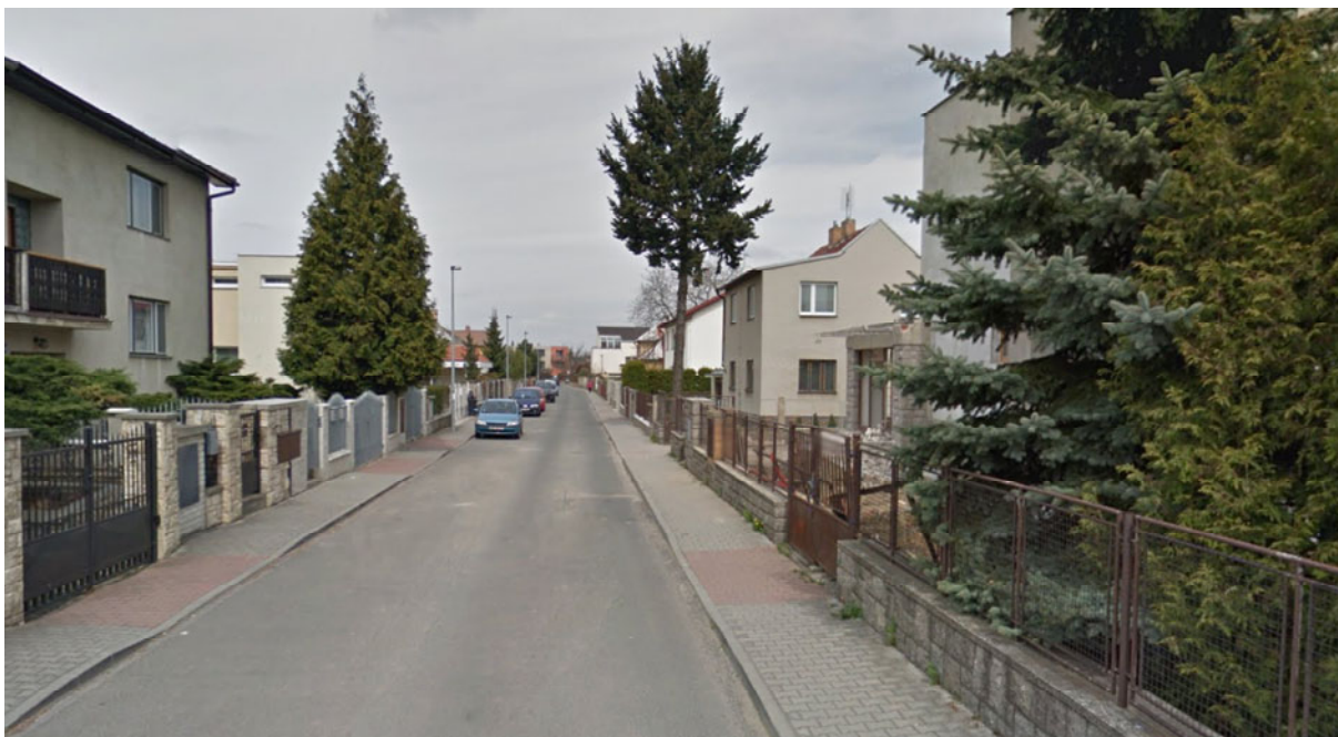
Obr. 14: Ulice Kudeříková – Rekonstrukce rok 2000
