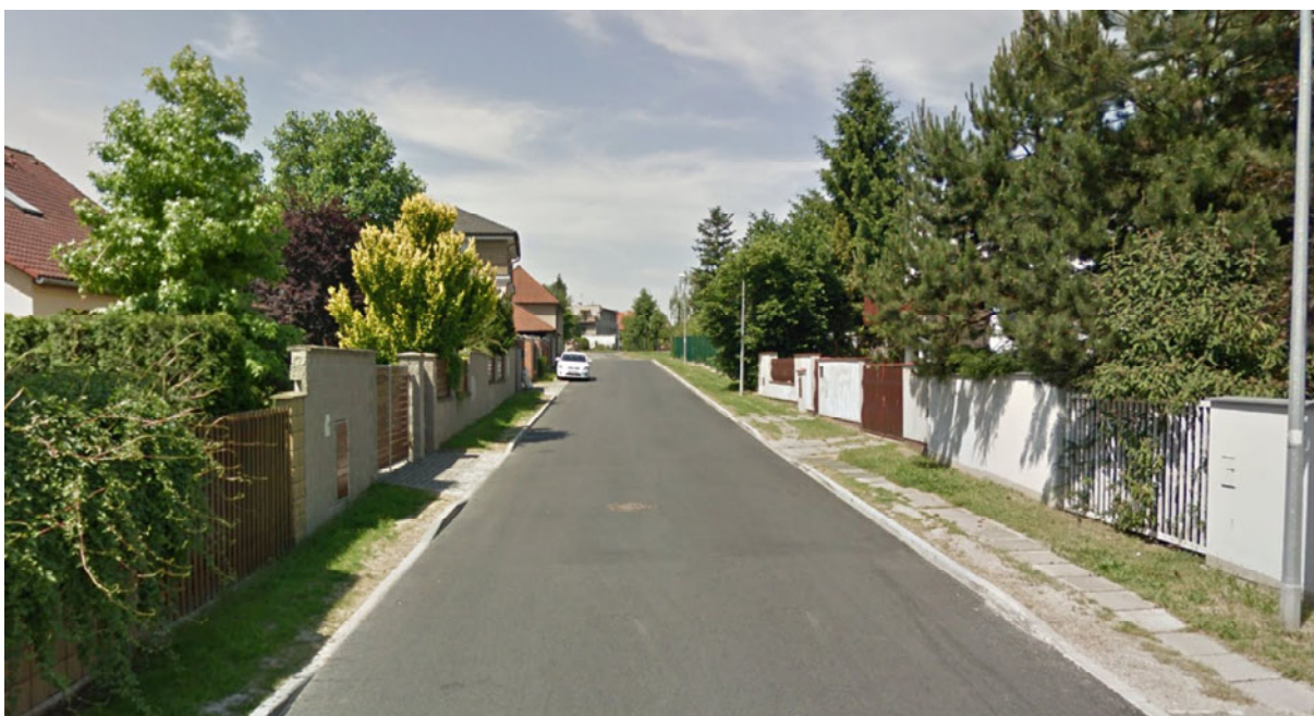
Obr. 22: Ulice Ještědská – Rekonstrukce rok 2012-13
