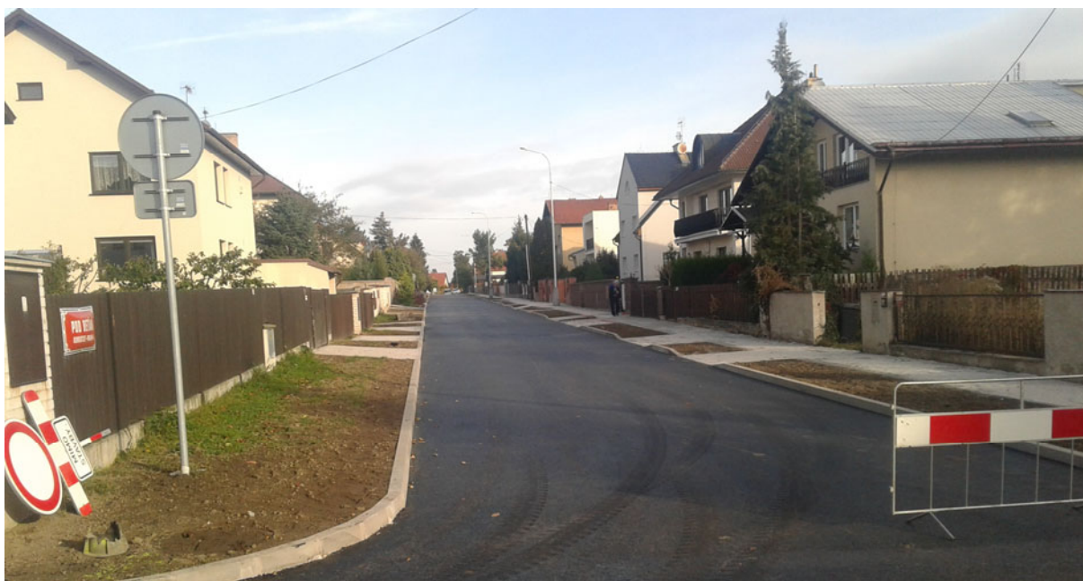
Obr. 26: Ulice Pod Betání -Rekonstrukce rok 2016-17
