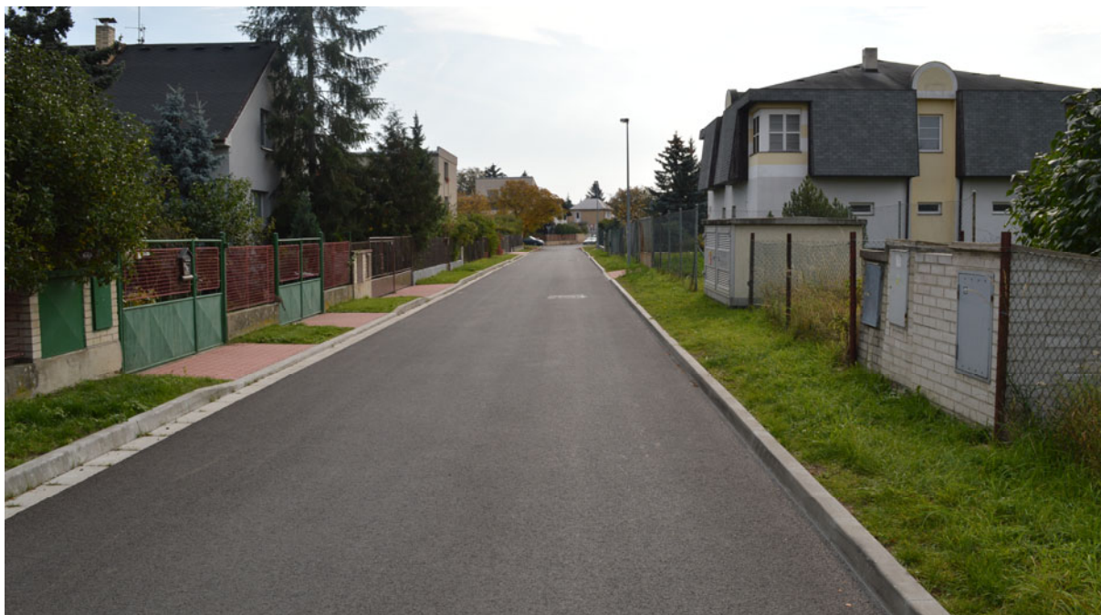
Obr. 25: Ulice Pražského povstání – Rekonstrukce rok 2016-17
