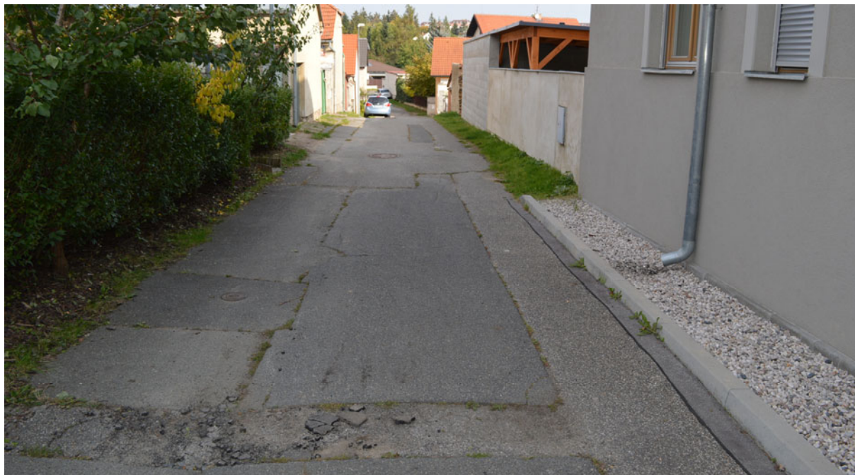
Obr. 10: Ulice Za Studánkou – pohled z ulice Ještědská
