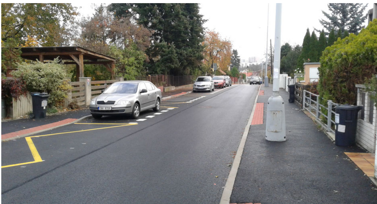
Obr. 28: Ulice Děbolínská po rekonstrukci – Rekonstrukce rok 2016-17
