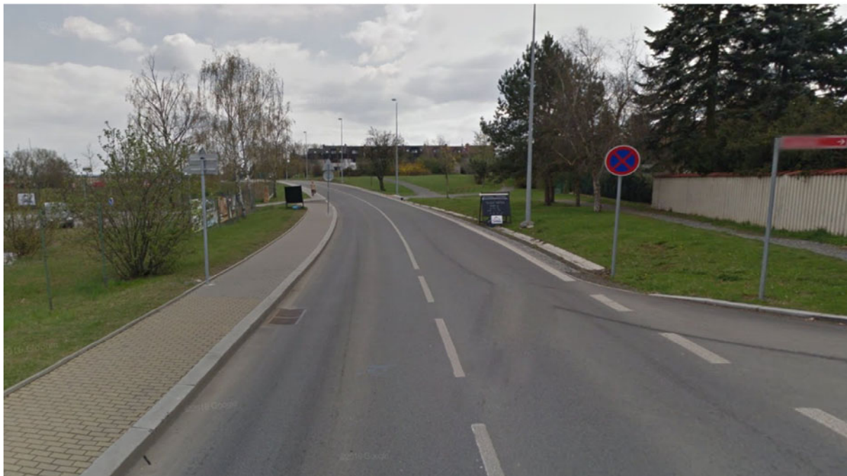
Obr. 19: Ulice K Šeberáku – Rekonstrukce rok 2010
