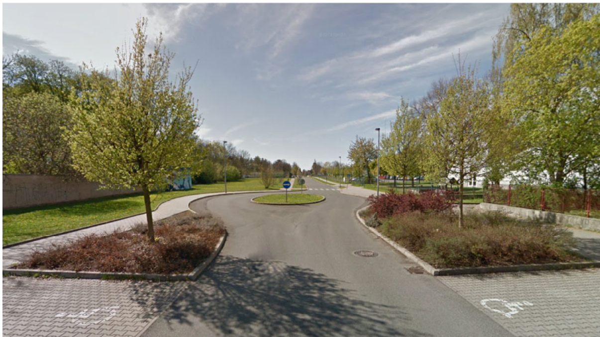
Obr. 13: Ulice Za Parkem – Rekonstrukce rok 2000
