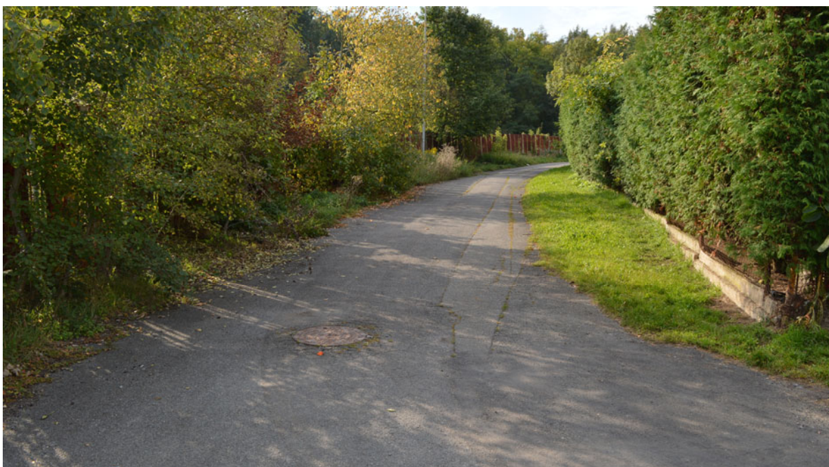
Obr. 34: Ulice Dřevnická – pohled z ulice Úhlavská – úsek 5
