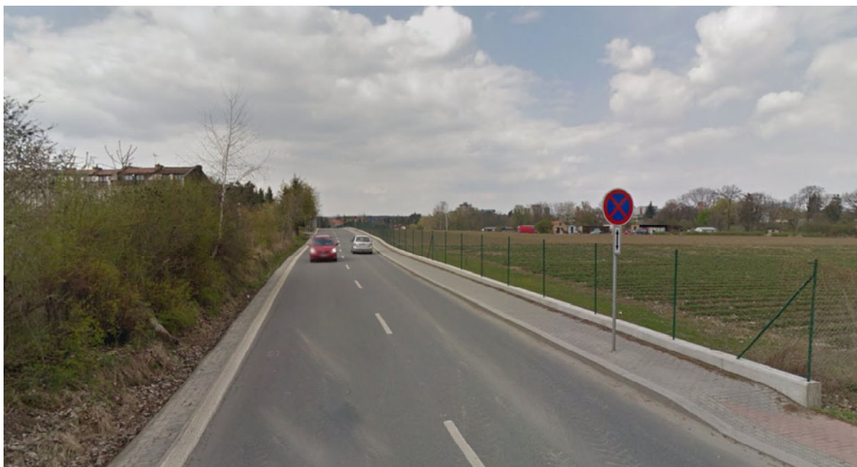
Obr. 20: Ulice K Šeberáku – Rekonstrukce rok 2010
