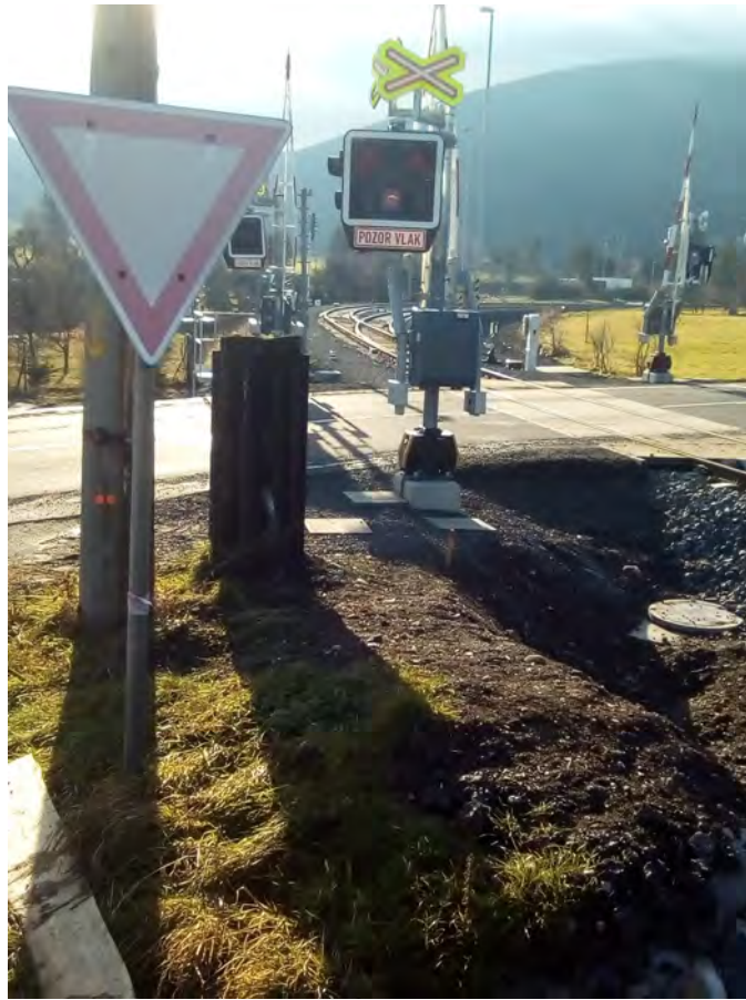
Foto 29: Železniční přejezd st. 25,828
