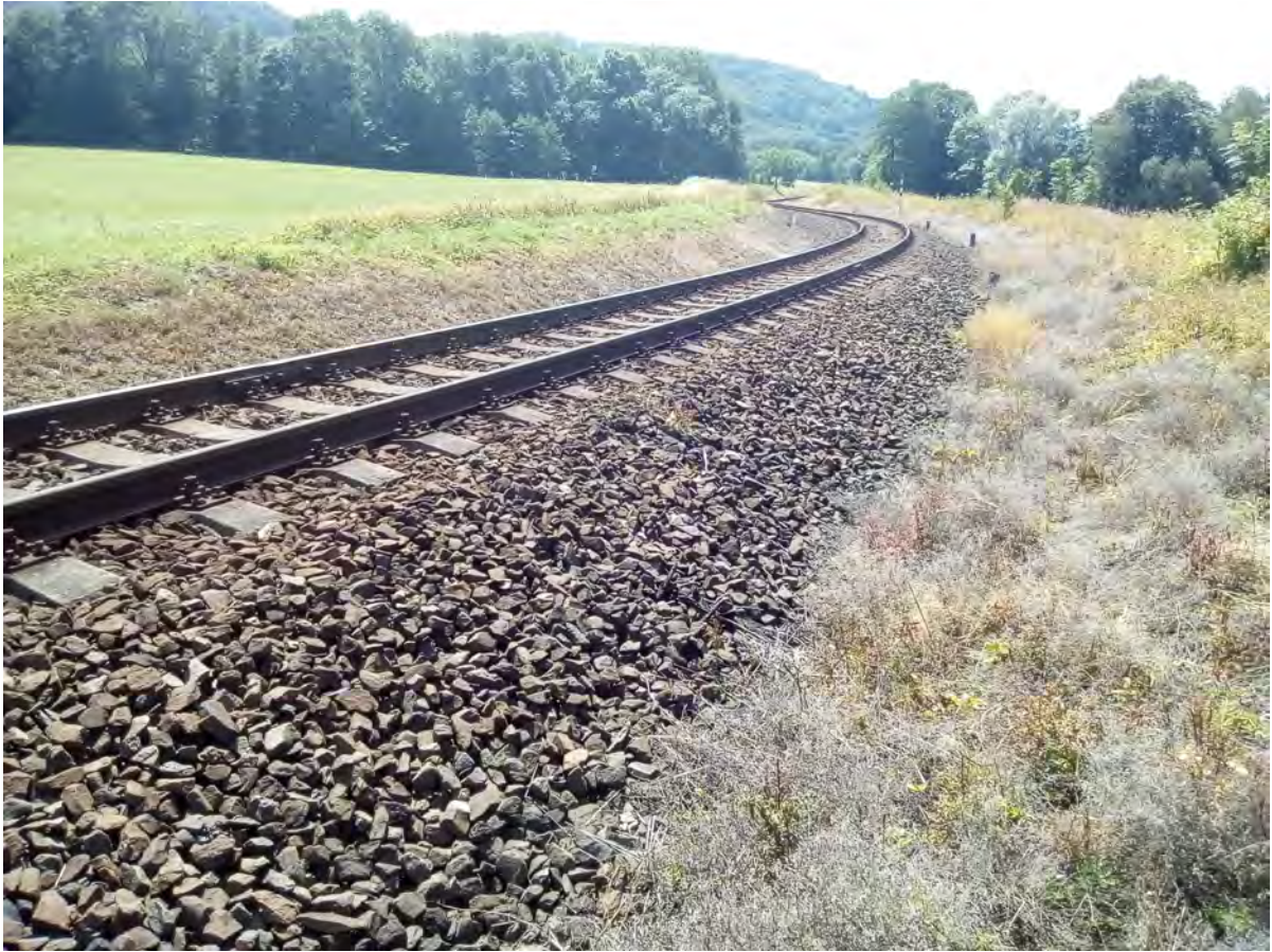
Foto 58: směrové oblouky R=180\text{ m} a R=265\text{ m}
