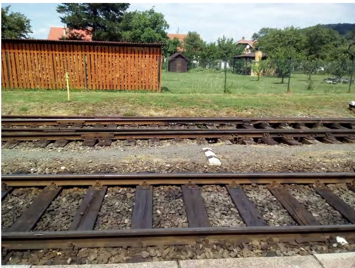
Foto 12: kolejště trati č. 325 před staniční budovou
