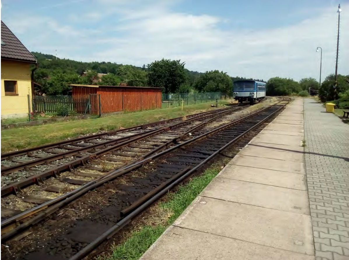
Foto 10: kolejště trati č. 325 před staniční budovou
