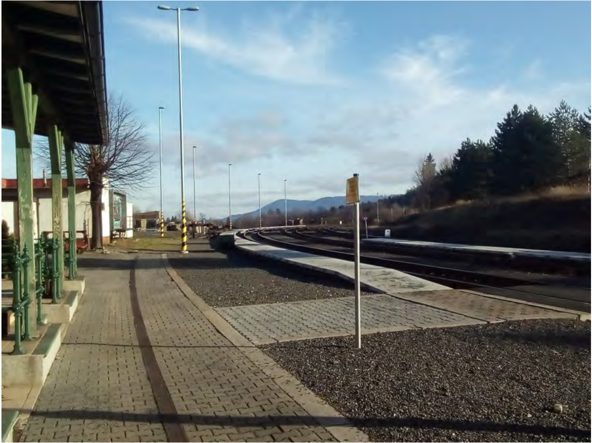
Foto 37: pohled na nástupiště v oblouku
