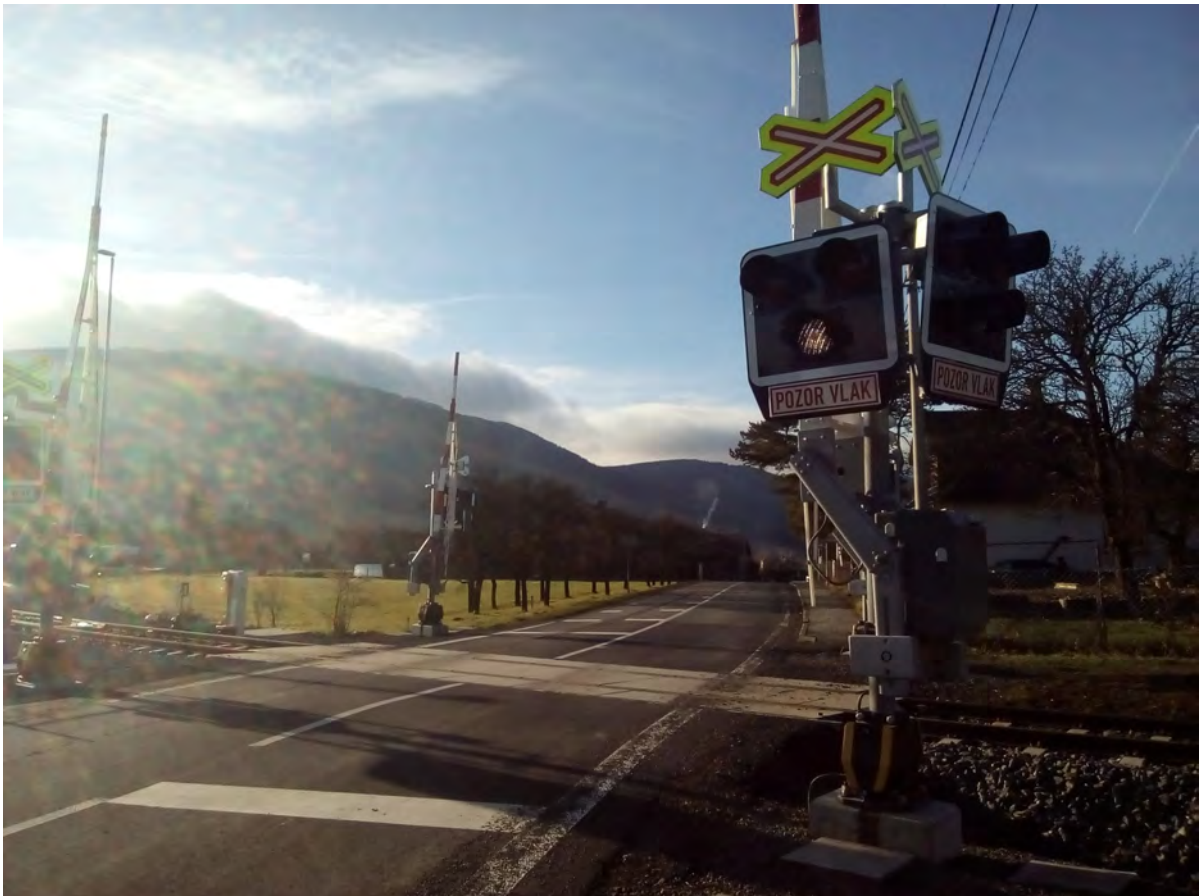
Foto 24: železniční přejezd st. 25,828
