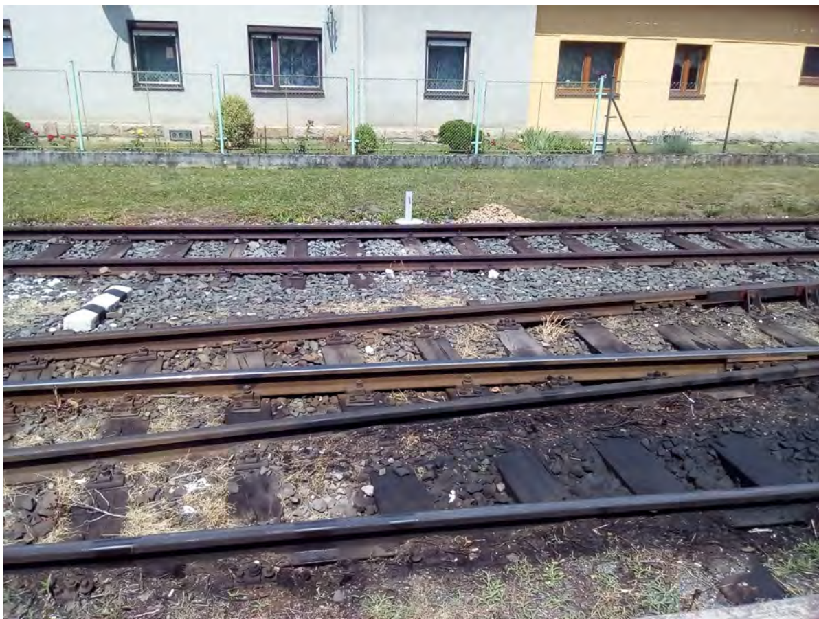
Foto 11: kolejště trati č. 325 před staniční budovou
