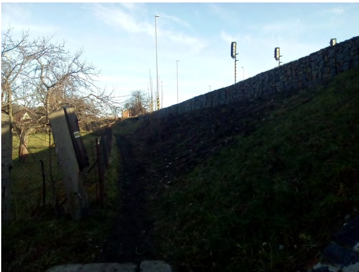
Foto 19: pohled na násyp trati č. 325 - zaústění do žst Veřovice
