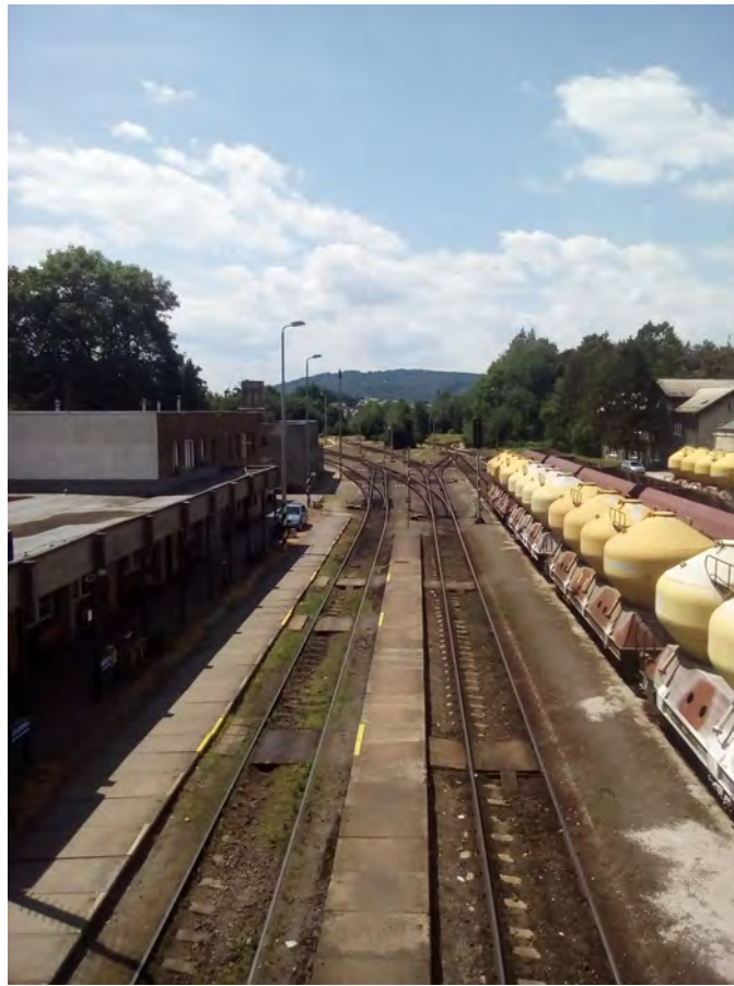
Foto 68: pohled na ŽST Štramberk - směr Vefovice
