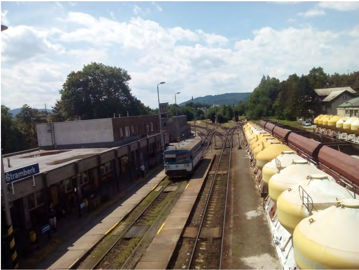
Foto 70: pohled na ŽST Štramberk - směr Vefovice
