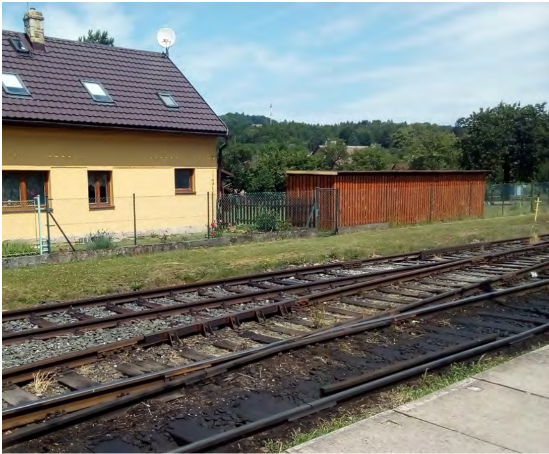
Foto 09: kolejště trati č. 325 před staniční budovou
