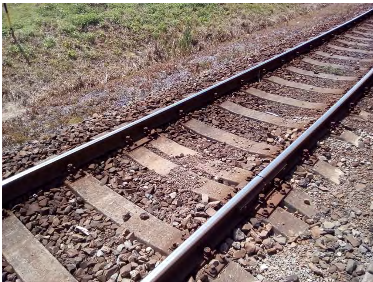
Foto 53: kolejiště trati č. 328 před staniční budovou
