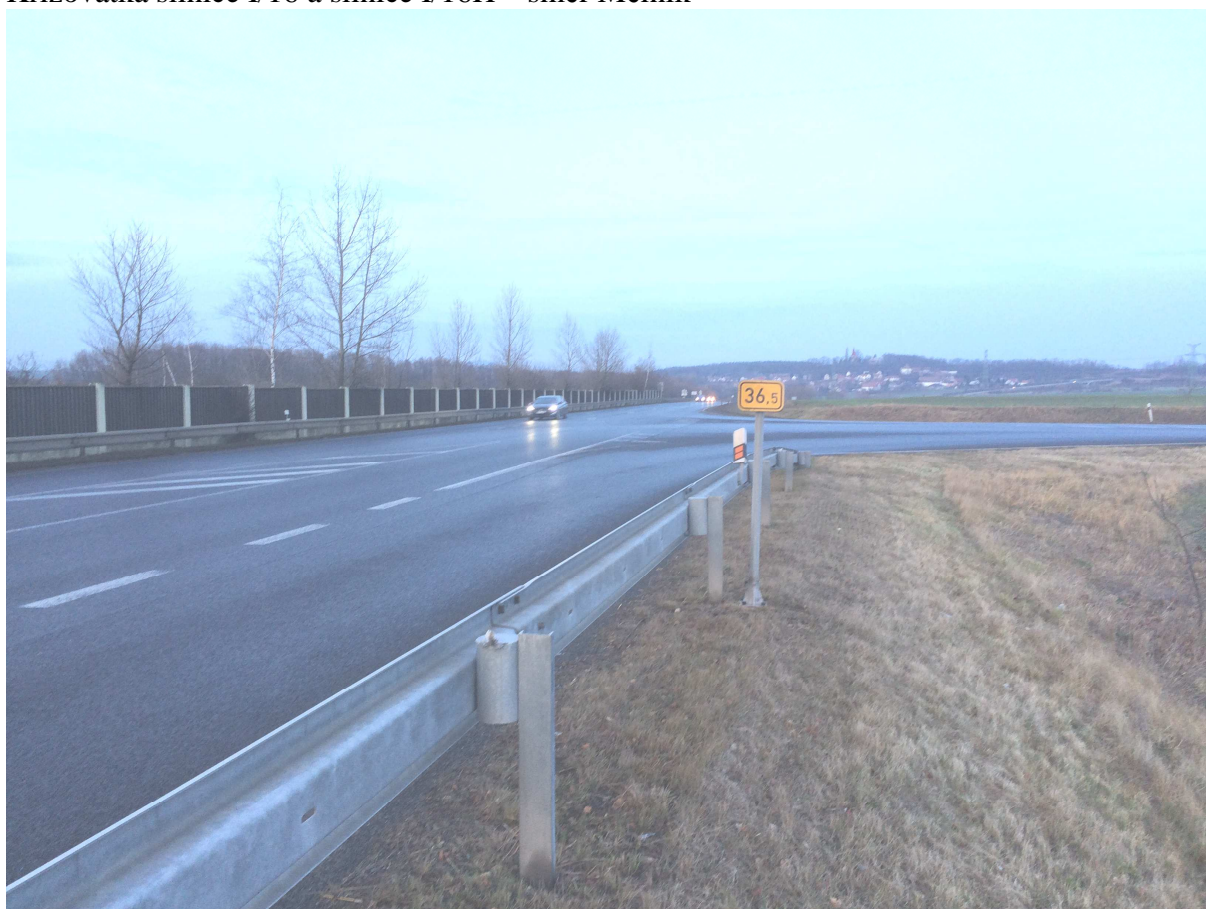
Křižovatka silnice I/16 a silnice I/16H – směr Mělník
