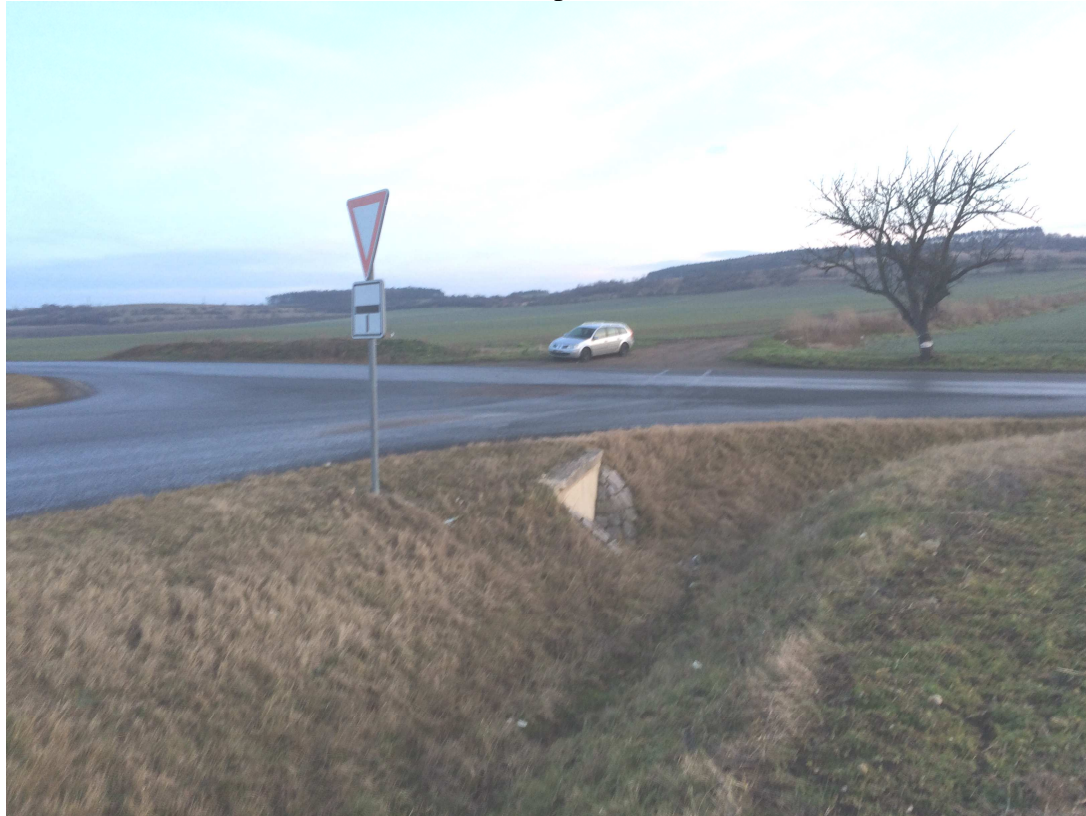
Křižovatka silnice II/616 a silnice I/16H – pohled od rušeného úseku
