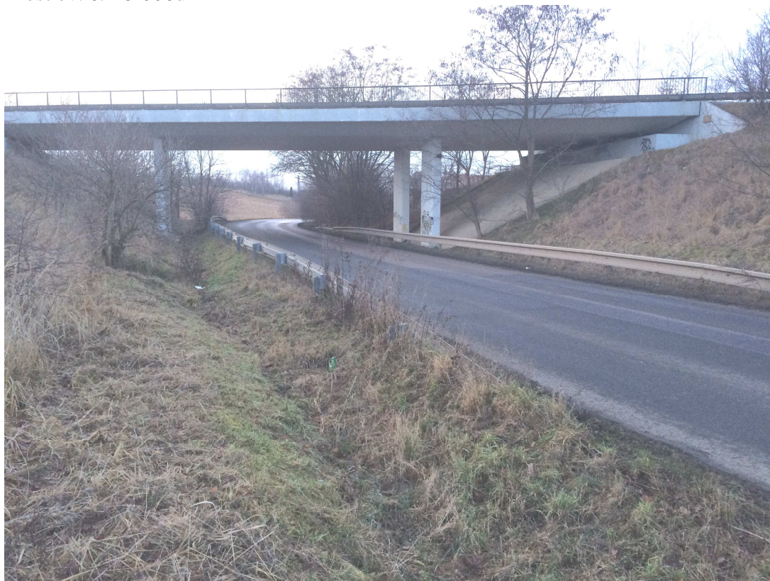
Most ev. č. 16-006d
