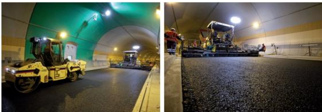
Obrázek 19: Pokládka v tunelu Blanka [38]
