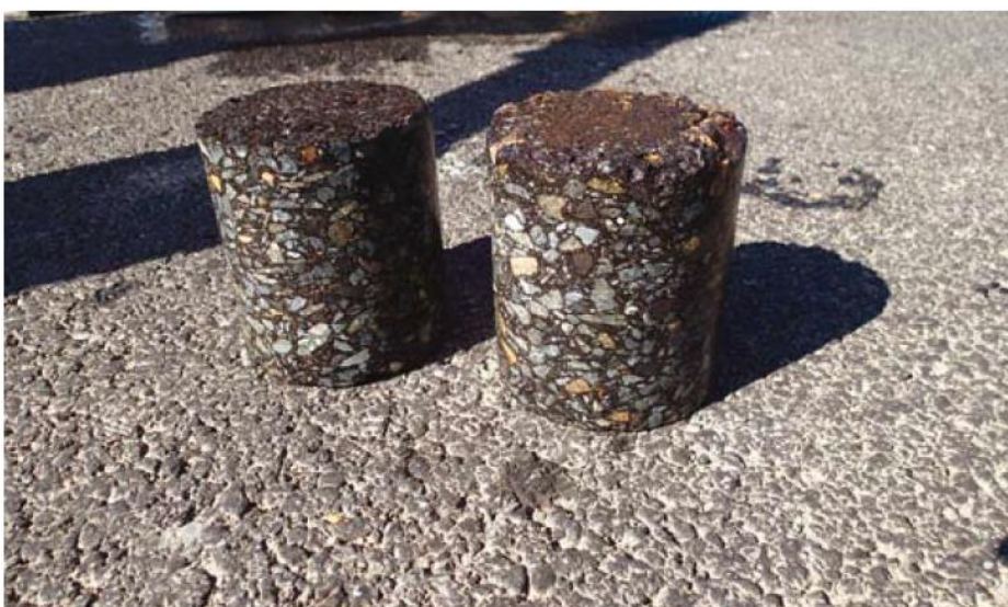
Obrázek 23: Jádrové vývrty vozovky s pěnoasfaltovou ložní vrstvou [41]
