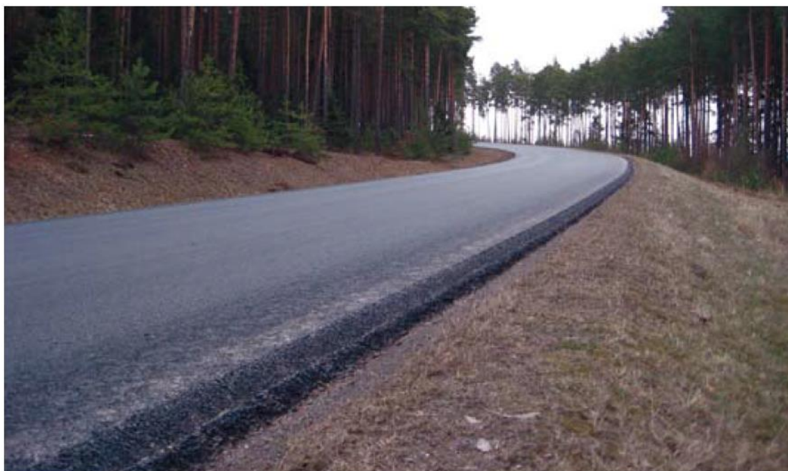
Obrázek 21: Pohled na výslednou položenou vozovku [41]
