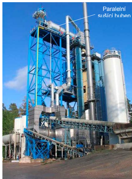
Obrázek 17: Paralelní sušící buben šaržové obalovny [31]
