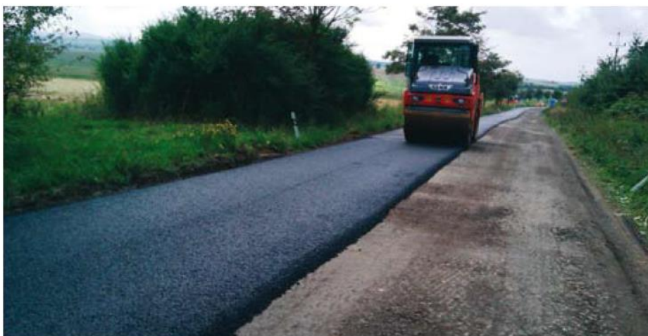
Obrázek 22: Hutnění NTAS s recyklátem [41]
