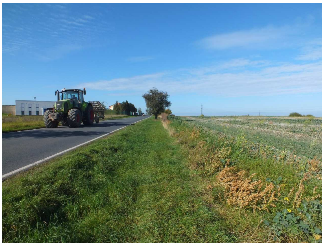
Pokračování cyklotrasy – úsek SO 101 – foto č.6
