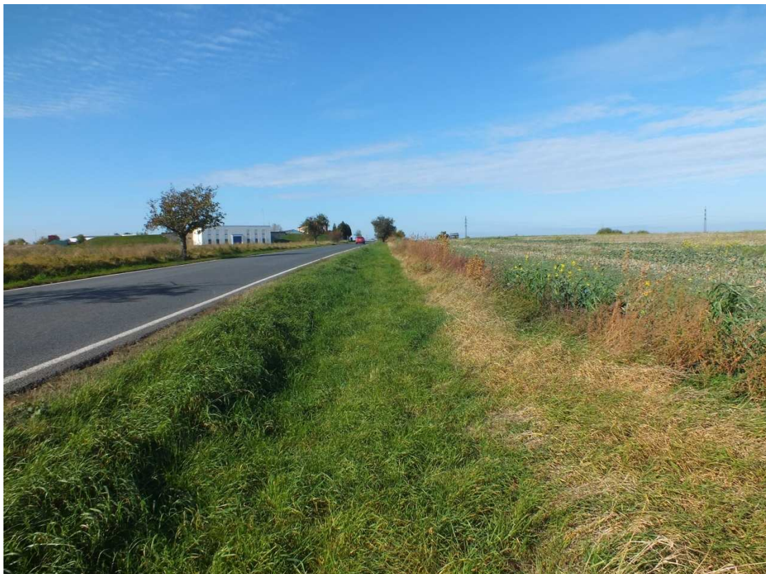
Pokračování cyklotrasy – úsek SO 101 – foto č.5
