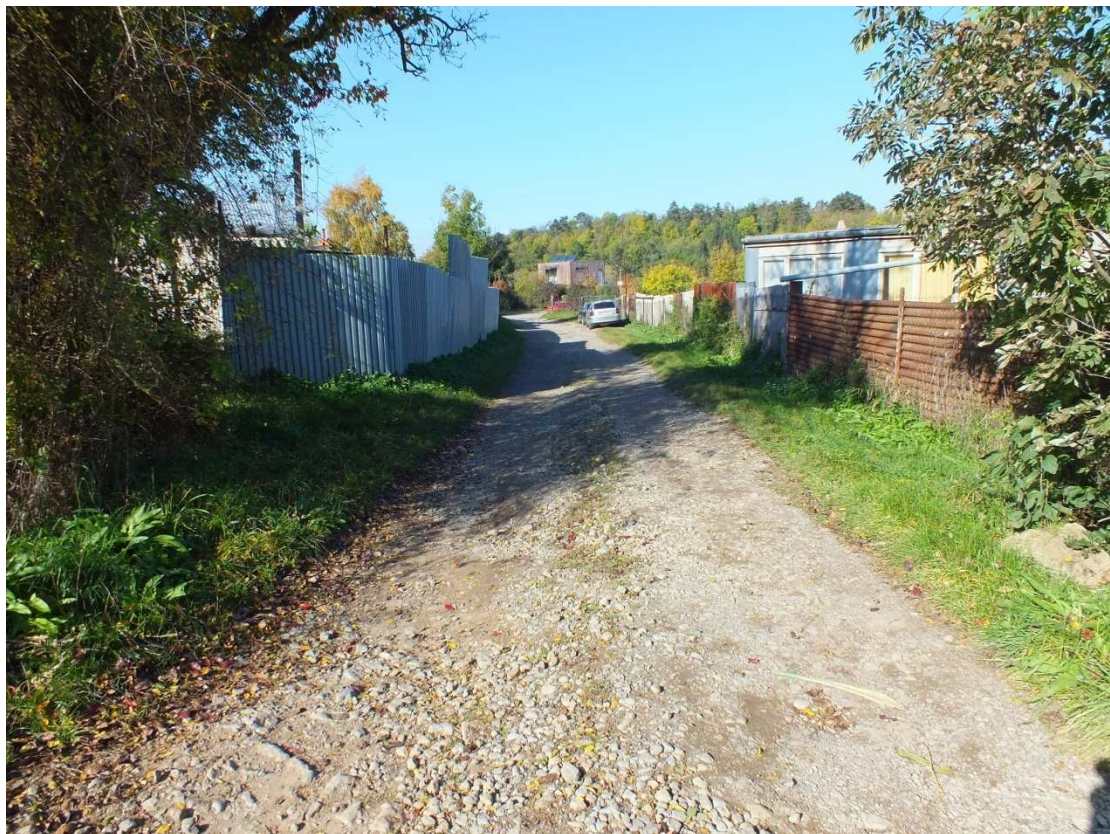
Pokračování cyklotrasy – úsek SO 103 – foto č.33
