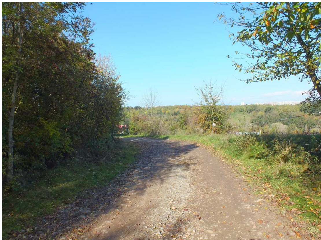
Pokračování cyklotrasy – úsek SO 103 – foto č.27
