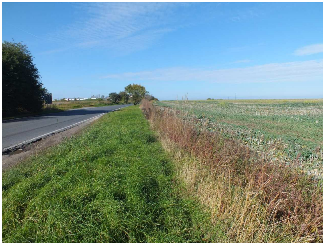
Pokračování cyklotrasy – úsek SO 101 – foto č.2
