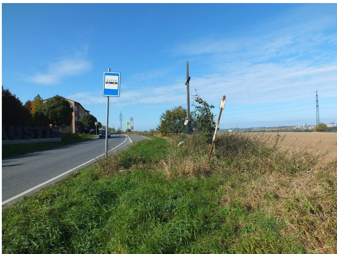
Pokračování cyklotrasy – konec úseku SO 101 – foto č.10
