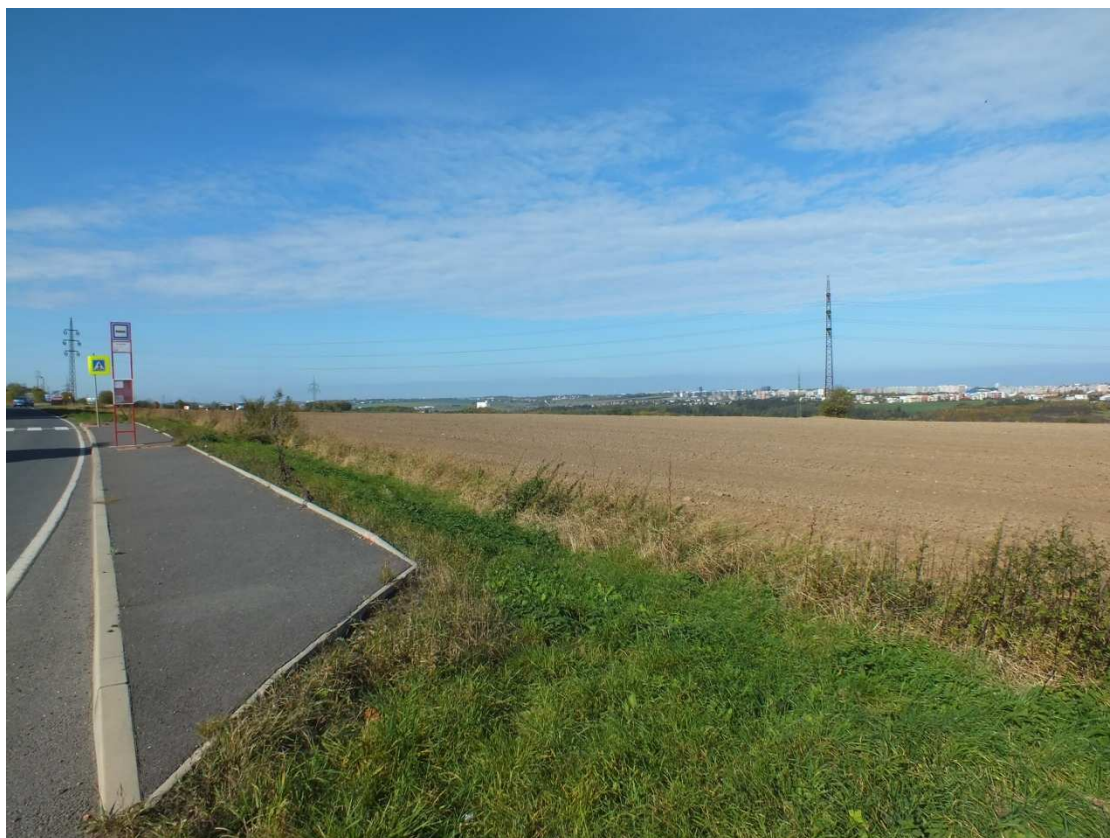
Pokračování cyklotrasy – počátek úseku SO 102 – foto č.11
