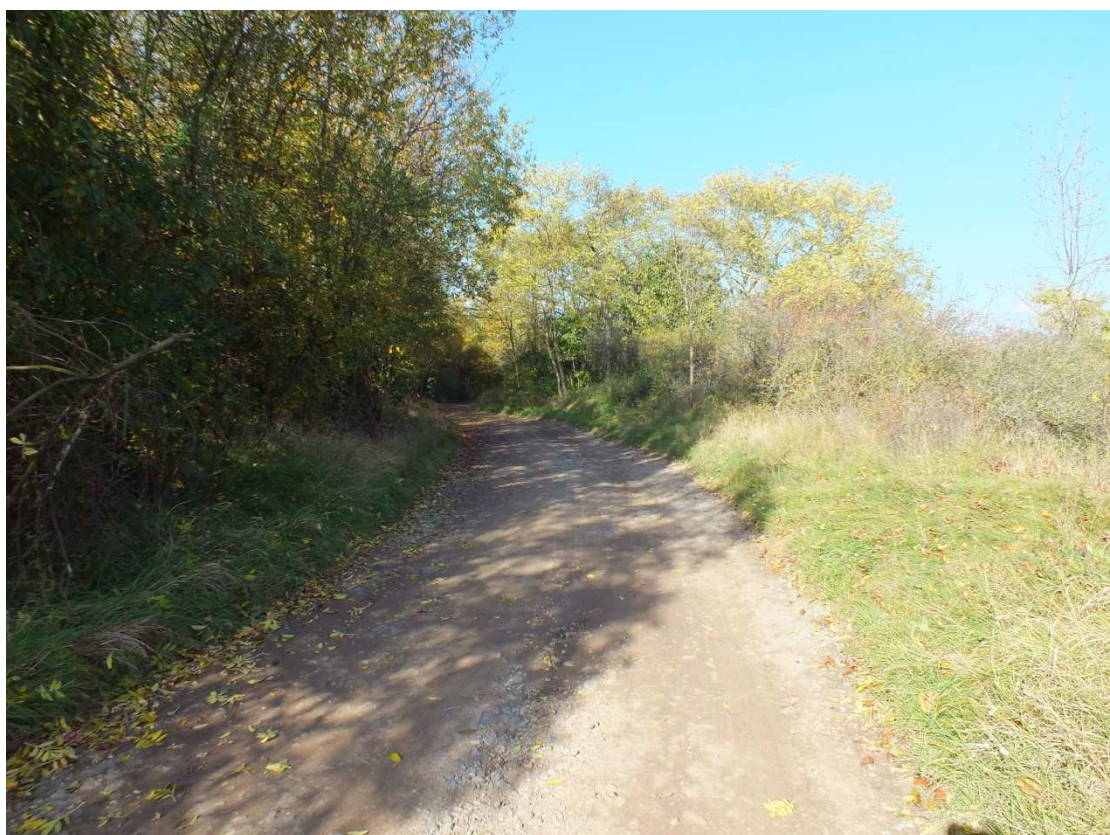
Pokračování cyklotrasy – úsek SO 103 – foto č.24
