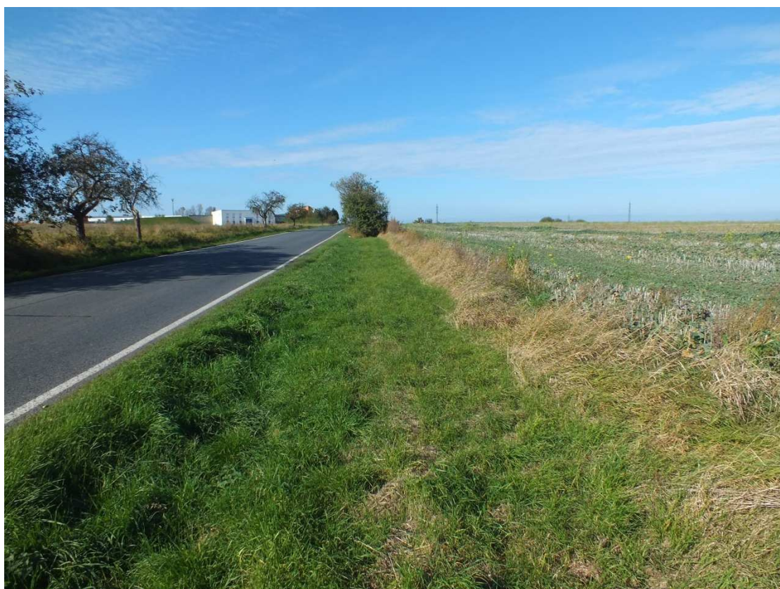
Pokračování cyklotrasy – úsek SO 101 – foto č.4
