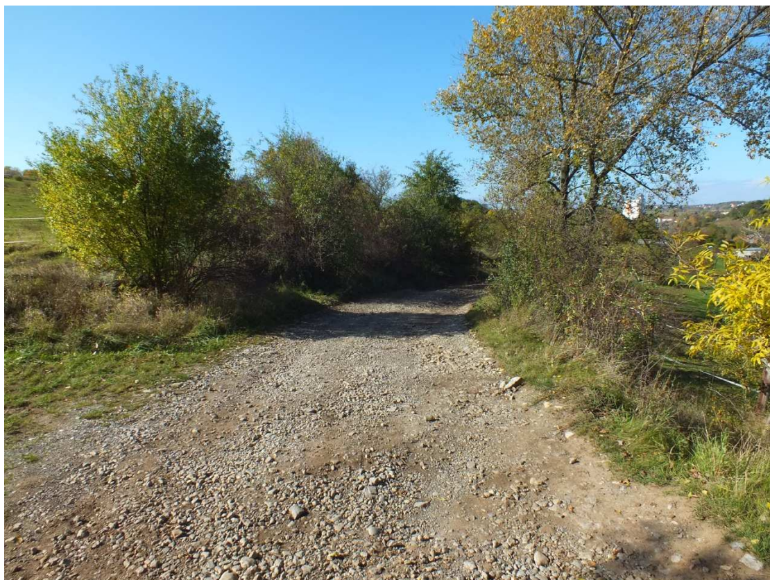
Pokračování cyklotrasy – úsek SO 103 – foto č.31
