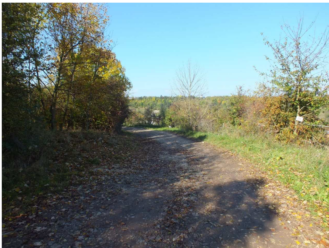
Pokračování cyklotrasy – úsek SO 103 – foto č.28
