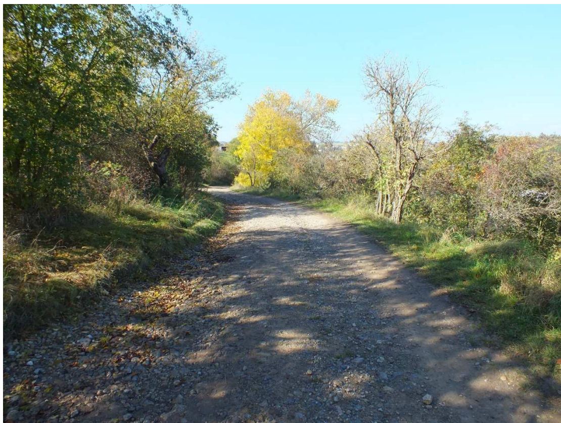
Pokračování cyklotrasy – úsek SO 103 – foto č.30
