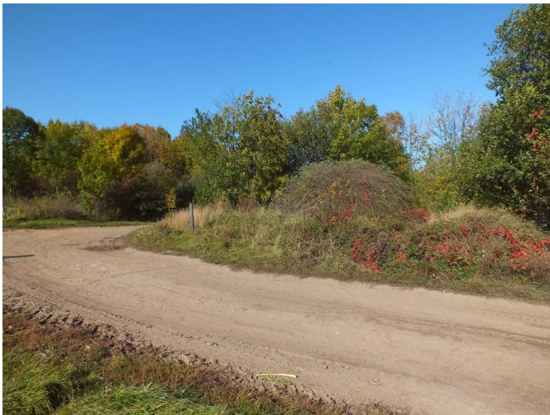
Pokračování cyklotrasy – začátek úseku SO 103 – foto č.22
