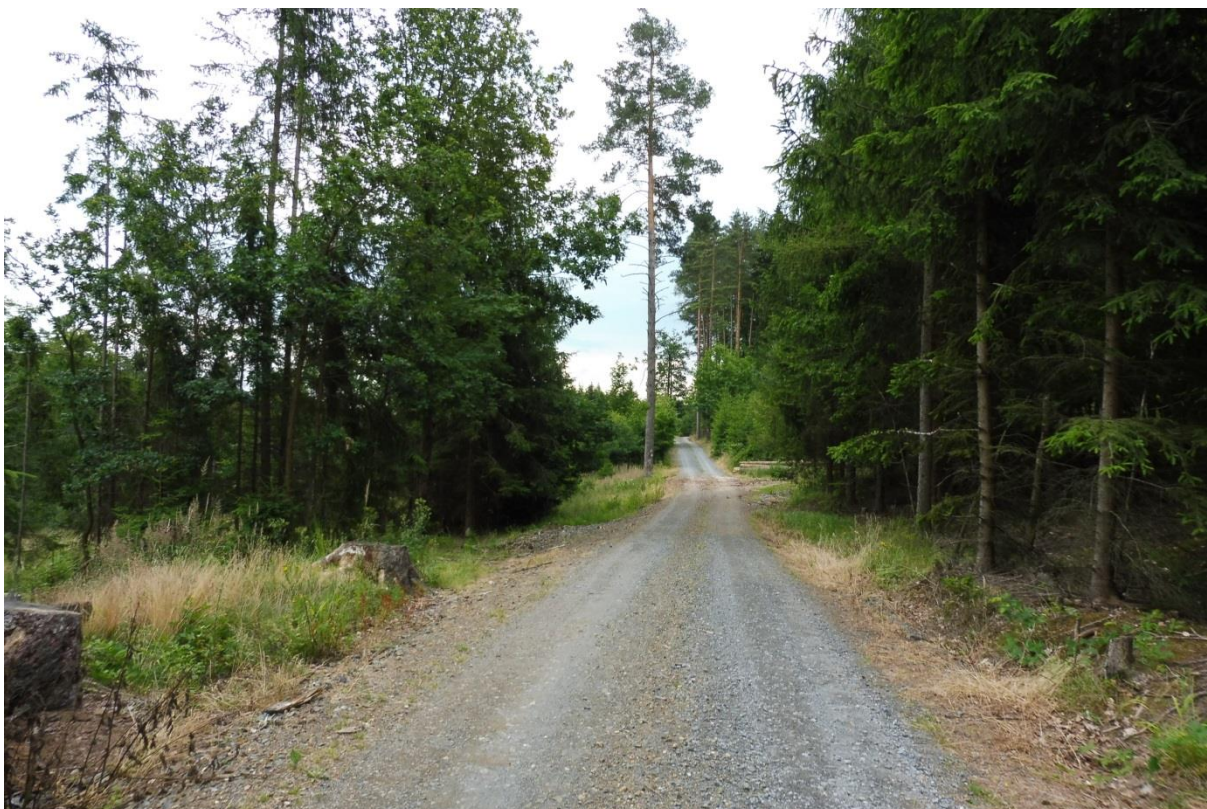
Fotografie 14 Cesta s příkopem v nedobrému stavu
