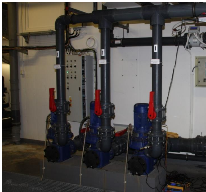
Obr. 7.14 – Tři čerpadla BADU ® Block 65/250 [ŠVEJDOVÁ, Nikola. © 2017.]
