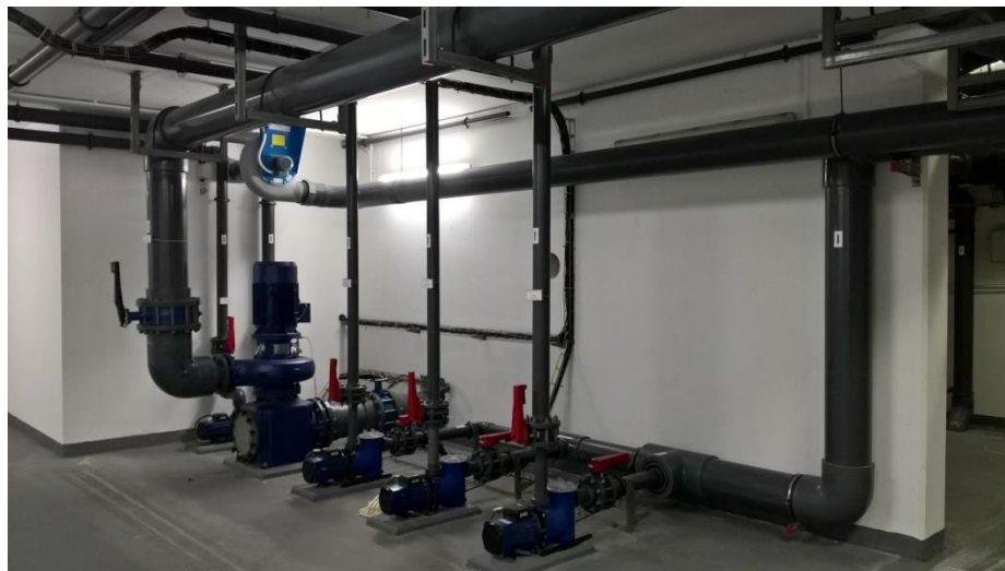
Obr. 8.56 – Pohled na soustavu divokého kanálu [ŠVEJDOVÁ, Nikola. © 2017.]
