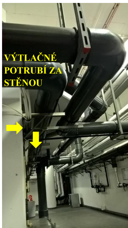
Obr. 8.69 – Výtláčné potrubí [ŠVEJDOVÁ, Nikola. © 2017.]
