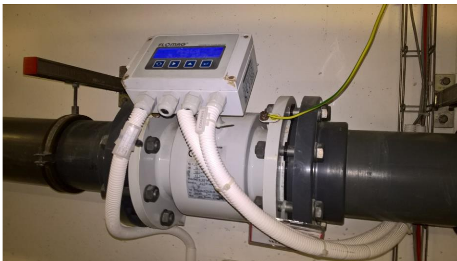
Obr. 8.44 – Indukční průtokoměr [ŠVEJDOVÁ, Nikola. © 2017.]
