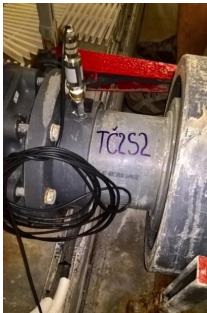
Obr. 8.25 – Tlakové čidlo na sání TČ2S2 [ŠVEJDOVÁ, Nikola. © 2017.]
