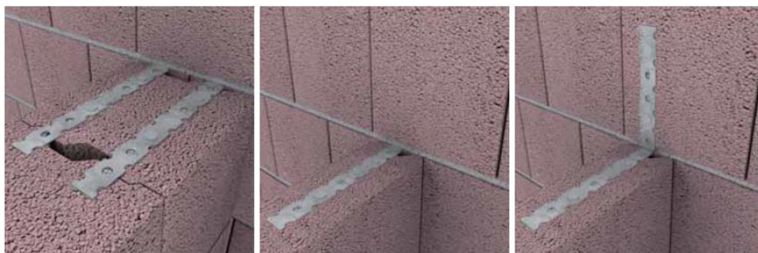
Obrázek 5: Napojení zdiva pomocí pásek pro stěny širší než 240 mm a 175 mm (2)
