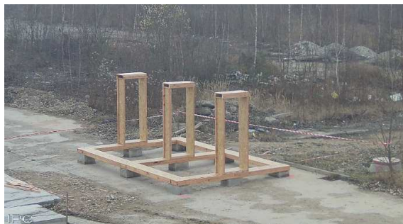
Obr. 15 - Základy po osazení kastlíků pro dveře
