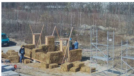
Obr. 18 - Založení svislých nosných stěn
