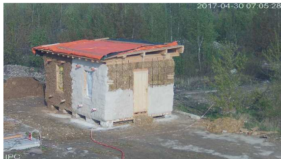
Obr. 23 - Realizace podhozové vrstvy
