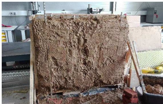
Obr. 53 - Nanášení hrubé vrstvy omítky
