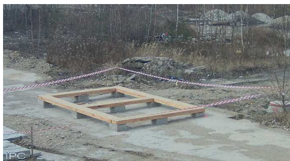
Obr. 14 - Základy s osazeným spodním věncem
