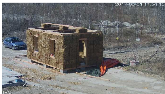
Obr. 20 - Stažení objektu páskami
