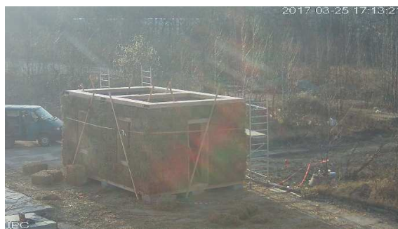
Obr. 19 - Svislé nosné stěny po osazení věnce
