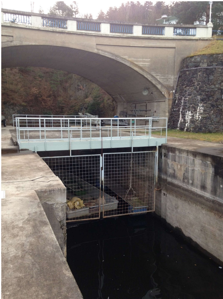
Obr. 3.10 Část plavební komory lodního zdvihadla
