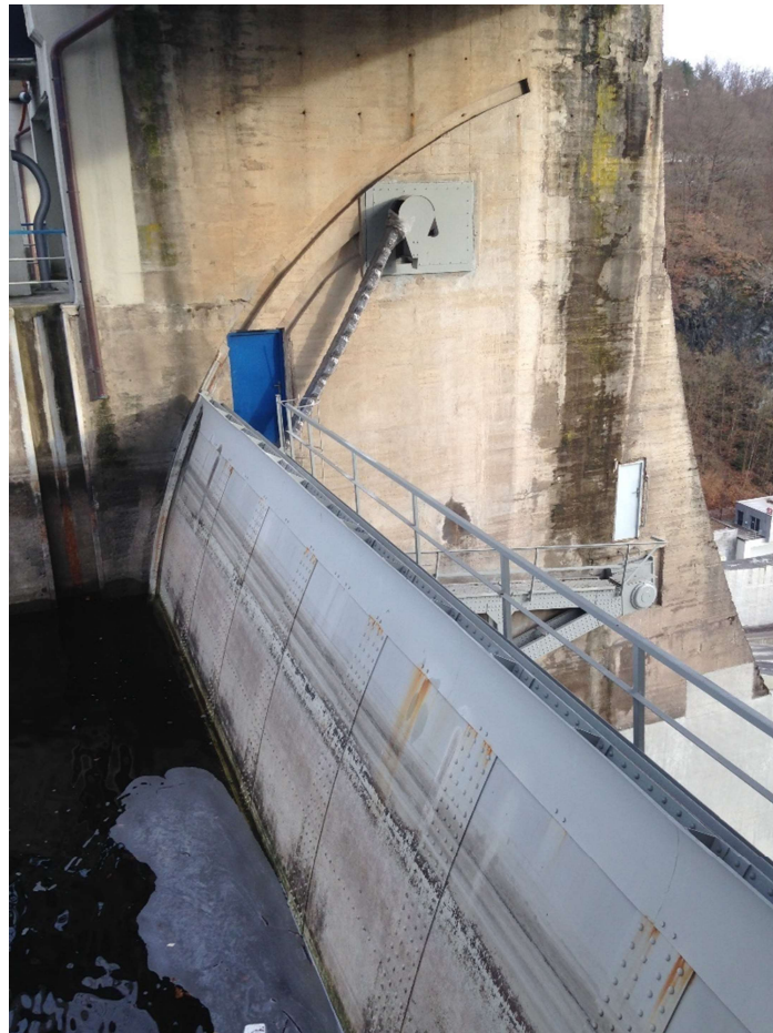
Obr. 3.6 Segmentový uzávěr
