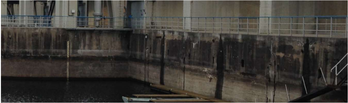
Obr. 8.1 Zábradlí na pochozí plošině
