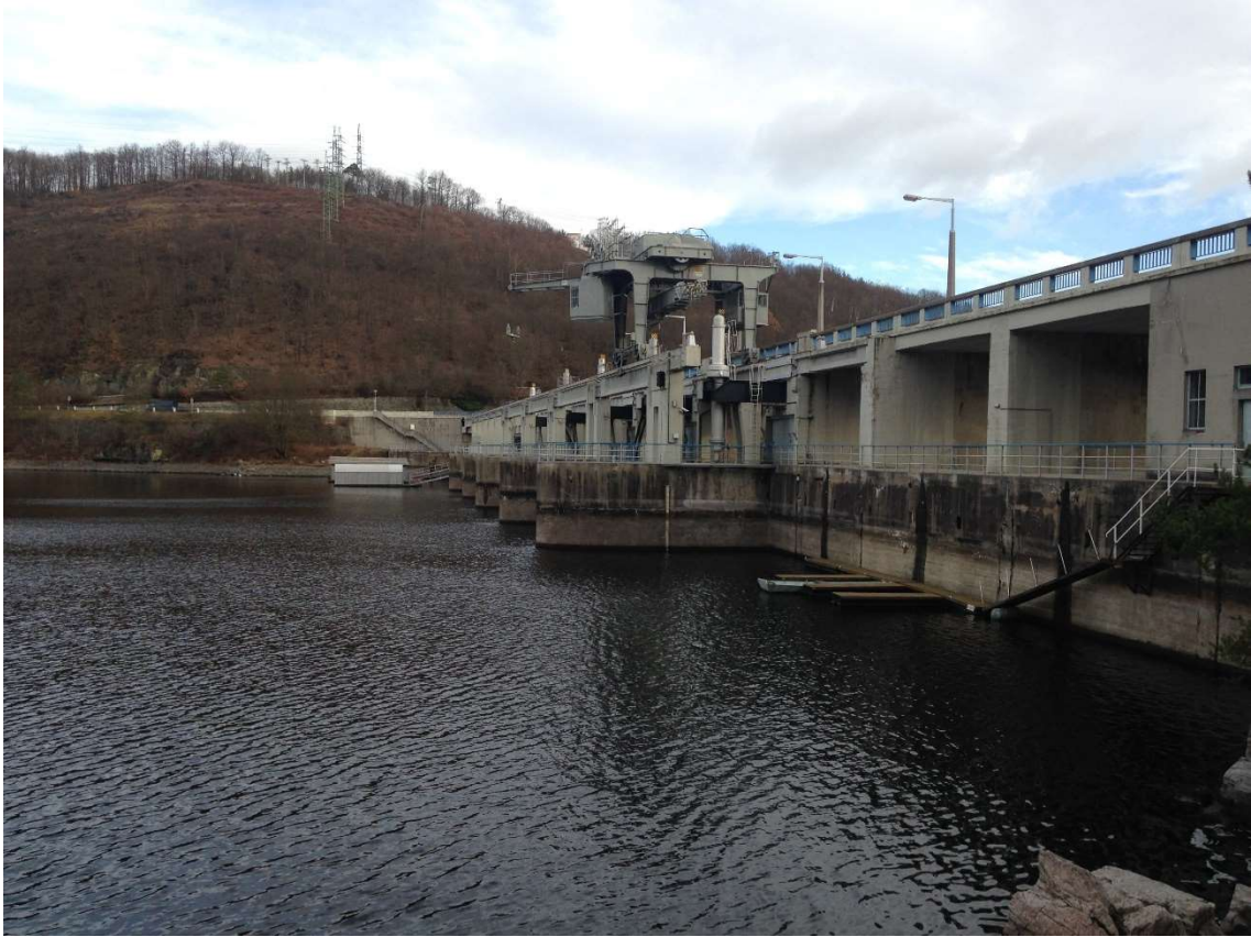
Obr. 3.3 Pochozí návodní strana s jeřábem
