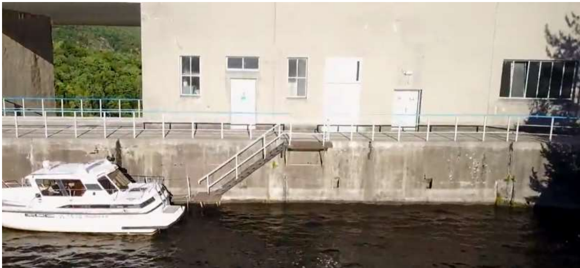
Obr. 8.2 Přístup ke kotvicím lodím [24]
