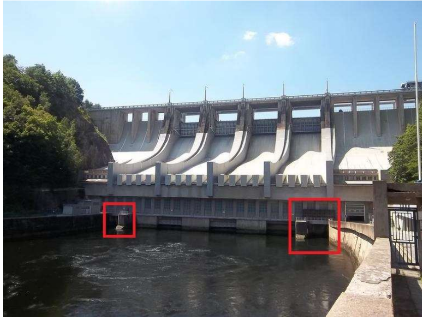
Obr. 3.4 Umístění spodních výpustí [8]
