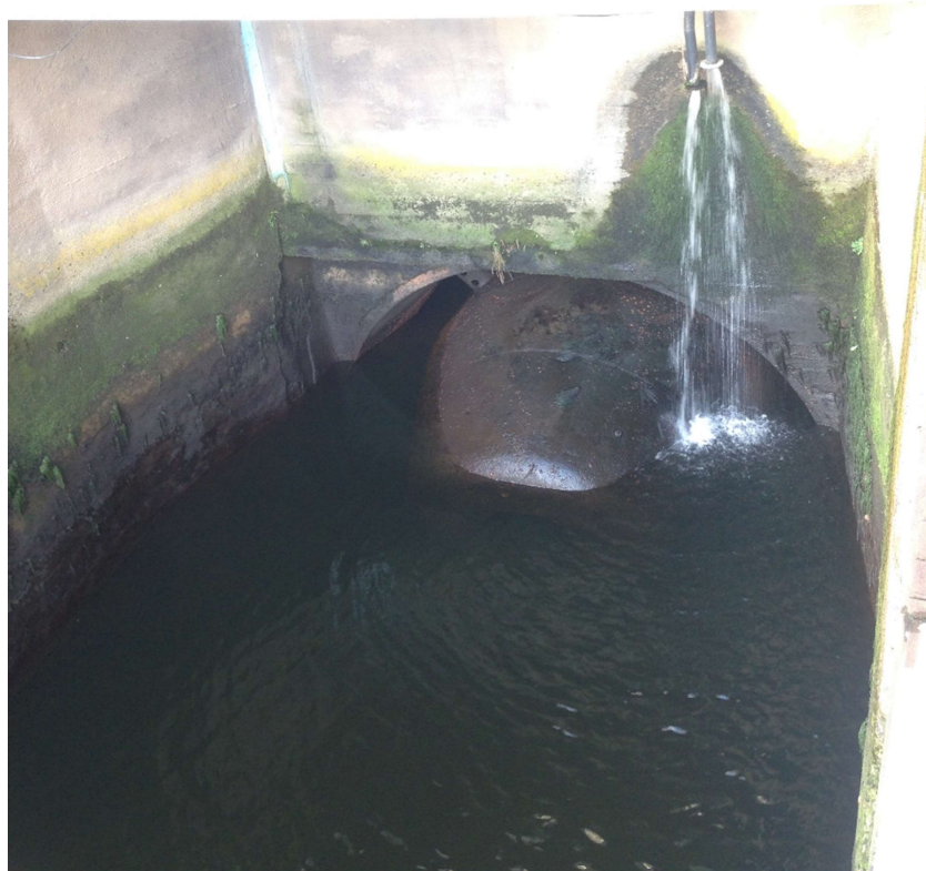
Obr. 3.5 Detail potrubí spodní výpusti
