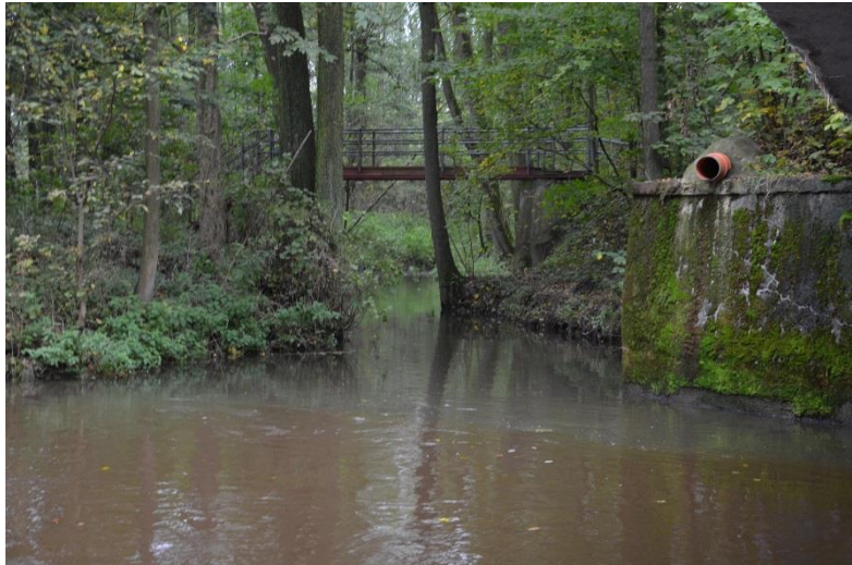
Foto 29 Ústí potoku Olešnice do řeky Úpy u Vilémova mostu, ř. km 14,645
