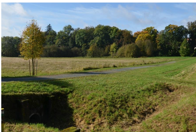
Foto 15 Pohled na inundační přeliv
