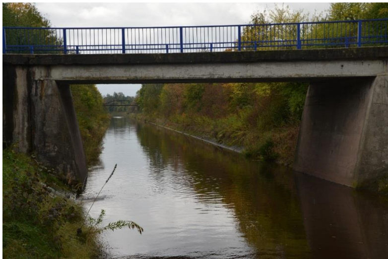
Foto 8 Silniční most ř. km 1,419
