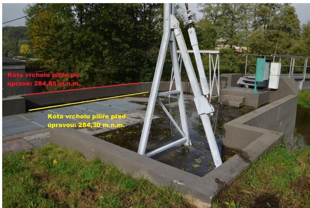
Obrázek 2.6 Levý jezový pilíř
