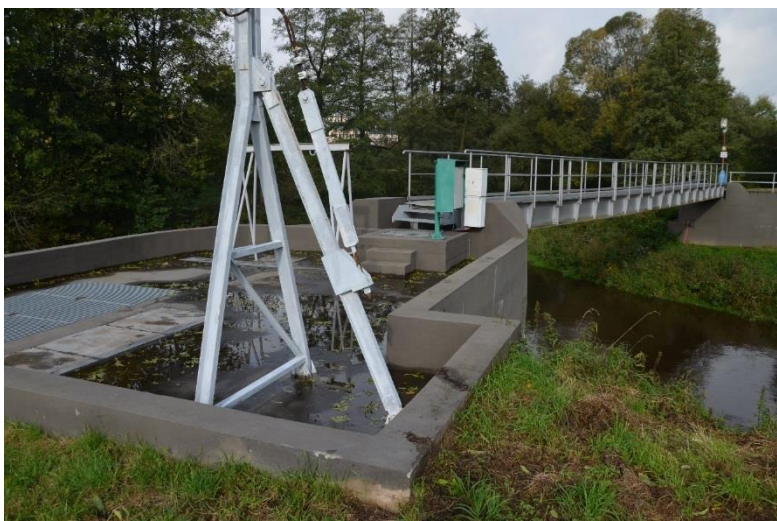
Foto 6 Pohled na levý pilíř jezu s lávkou
