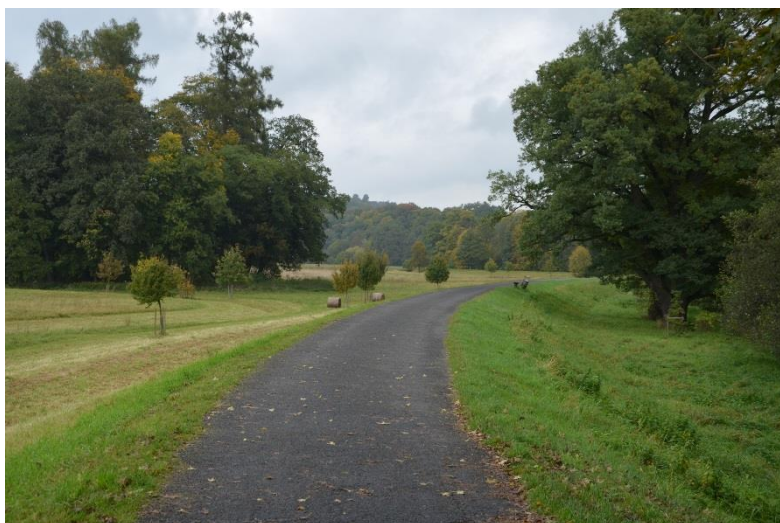
Foto 11 Hrázka s asfaltovou komunikací
