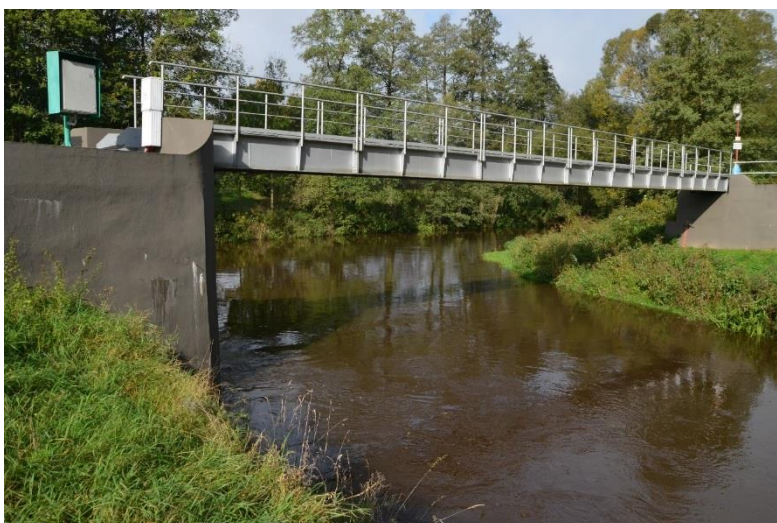
Foto 7 Nátok do přivaděče
