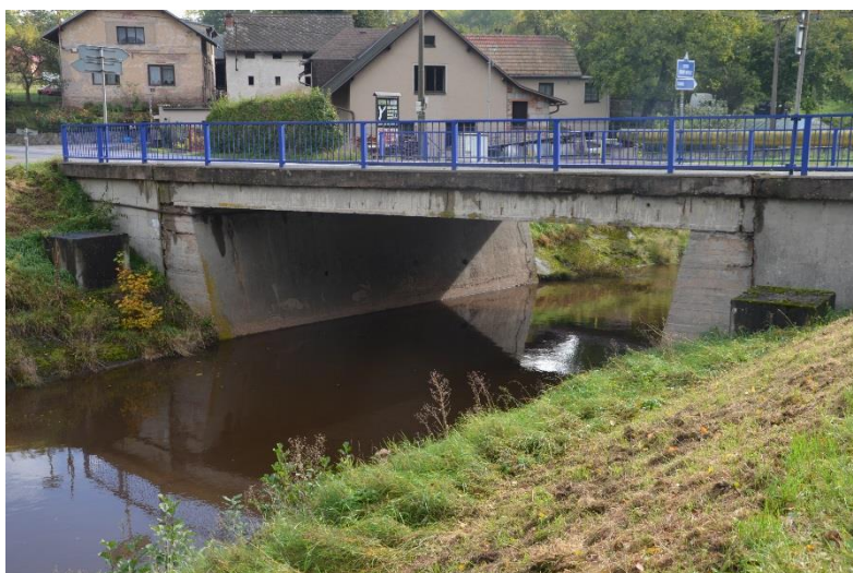
Foto 10 Silniční most v obci Zlích ř. km 1,945
