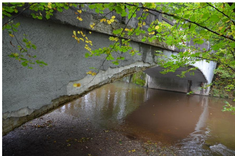
Foto 19 Vilémův most přes řeku Úpu I, ř. km 14,640
