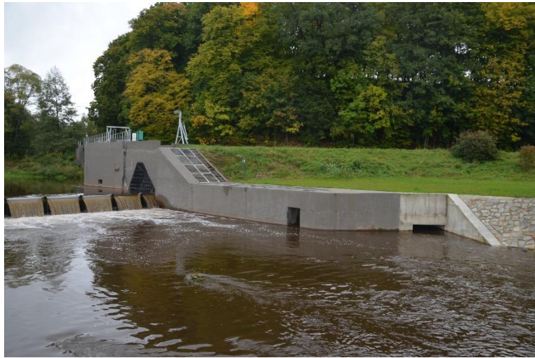
Foto 3 Pohled na pravý pilíř
