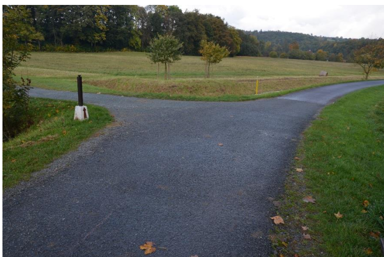
Foto 13 Napojení hrázky na inundační přeliv
