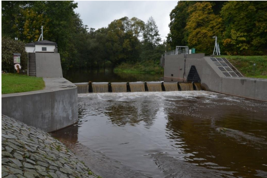
Obrázek 2.8 Jez ve Zličí, ř.km 14,780 – pohled proti proudu
