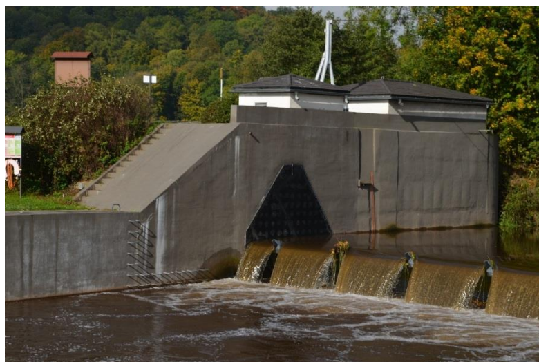
Foto 2 Pohled na pravý pilíř
