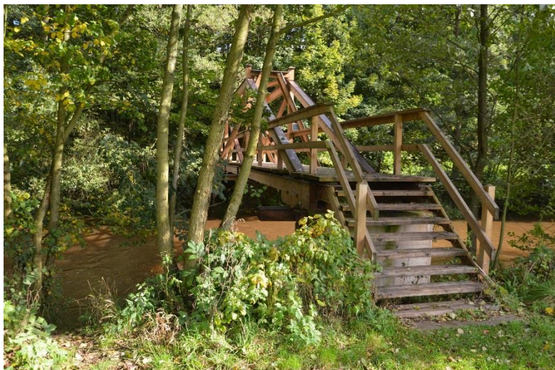
Foto 18 Lávka přes řeku Úpu, ř. km 16,000
