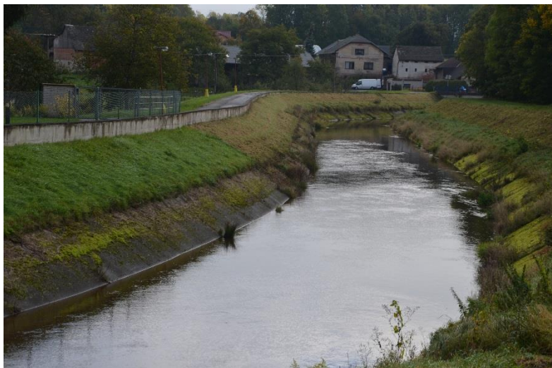
Foto 9 Vrchní úsek přivaděče
