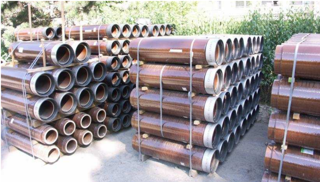
Obrázek 1.11 - Bezhrdlová kameninová trouba pro protlačování (KTP) – Keramo Steinzeug DN 300, použité na stavbě DIS Brno Tábor [5]
