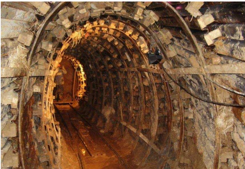
Obrázek 2.4 - Ukázka klasického štolování hornickým způsobem [28]
