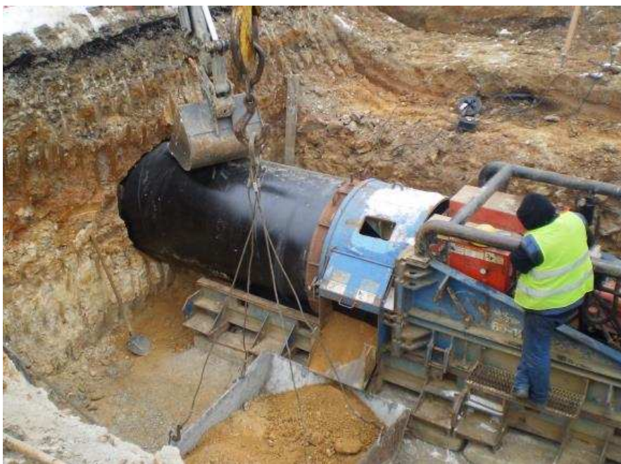
Obrázek 1.7 - Transport vytěžené zeminy, vrtná souprava American Augers 60-120 Turbo [5]
