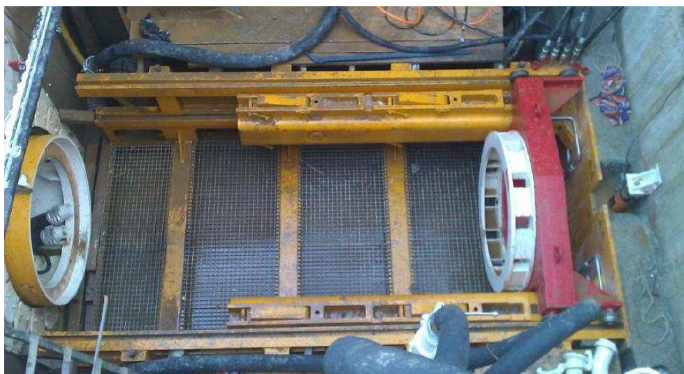
Obrázek 2.12 – Tlačný rám s hydraulickými písty [29]
