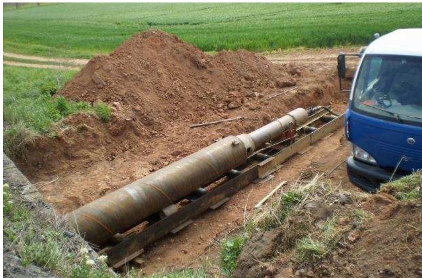
Obrázek 1.5 - Vodorovné beranění s otevřeným čelem, 500 Evos (Grundoram Koloss) [5]
