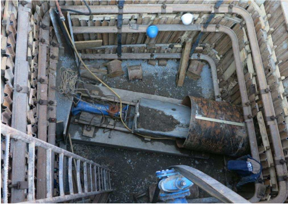
Obrázek 2.6 - Trubní protlak ocelové chráničky DN 1000 na stavbě odkanalizování Novomlýnské věže, Praha 1
