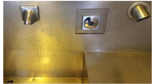
Obrázek 109: Bezkontaktní senzor časovače kohoutku s vodou umístěný mimo proud vody. K senzoru stačí přiblížit ruku a měla by se na určenou dobu spustit voda. Lepší je mít senzor rovnou zabudovaný u trysky s vodou, aby se při umístění rukou automaticky voda spustila a při oddálení zase vypnula. Senzor by měl jasně signalizovat, kde snímá a zda registroval požadavek.
