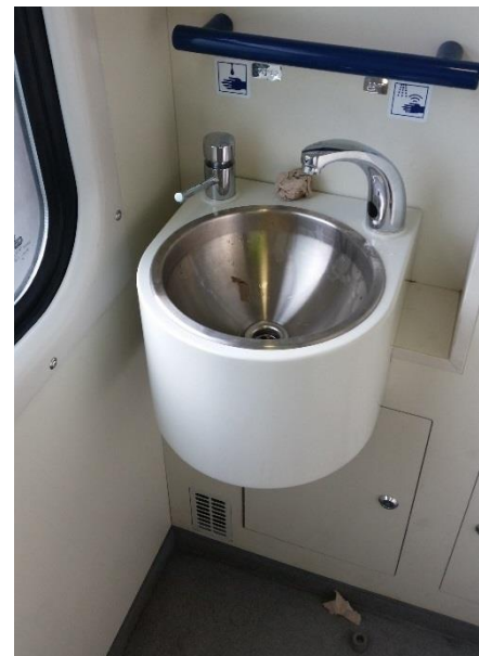
Obrázek 121: Nově zrekonstruovaná toaleta vypadá na první pohled velmi pěkně. Moderní automatický kohoutek na vodu a moderně vypadající zásobník na mýdlo vyvolávají pocit toalety v budově, a ne ve vlaku. Bohužel umyvadlo je velmi malé, takže bude docházet k rozstříkování vody na zem a okolní stěny. Z důvodu přítomnosti spár, předělů, hran, lišt a úzkých prostorů se tato voda bude špatně čistit a špatně přístupná místa okolo umyvadla se budou zanášet nečistotami a budou ničeny stojící vodou. Vhodnějším řešením je použití většího umyvadla vyrobeného z jednoho kusu spolu se stěnou za a vedle umyvadla, bez ponechání úzkých prostor okolo a svádějící všechnu vodu do odtoku.
