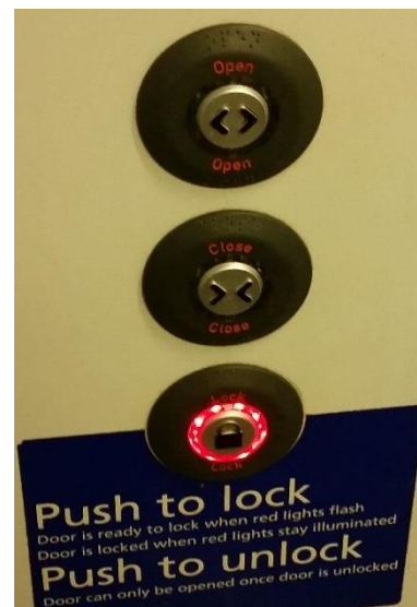
Obrázek 104: Vnitřní tlačítkové ovládání dveří toalety. Tlačítka jsou dostatečně velká pro ovládání např. loktem. Oddělení tlačítek otevření a uzavření se jeví jako vhodné, ale použití tlačítka pro uzamykání se bez dostatečných popisů jeví jako nevhodné. U tohoto vozidla je naštěstí funkce tohoto tlačítka poměrně dobře vysvětlena. Tlačítka mají výstupky pro rozpoznání nevidomým cestujícím, ale tato místa se budou špatně čistit a budou se na nich držet nečistoty.
