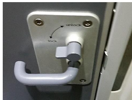
Obrázek 103: Jednoduché a familiární ovládání dveří od toalety klikou a mechanickým zámkem. Jediná škoda tohoto systému je, že zámek nelze odemknout bez použití prstů.
