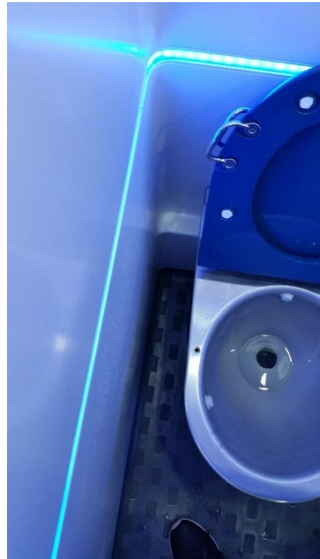
Obrázek 117: ASTRA Vagoane Calatori Bmpz A RJ. Toaletní mísa je umístěna příliš blízko stěny, takže na stěně budou ulpívat kapky vody rozprášené z toalety. Tento prostor vedle toalety se bude velmi špatně uklízet a budou v něm postupně narůstat nánosy nečistot. Toaletu by stačilo umístit o 150 mm více do prostoru a stěna vedle toalety by najednou šla lépe uklízet. Ostrý roh na záhybu stěny se bude špatně uklízet. Využití LED svítidel pro osvětlení toalety je velmi dobrý nápad pro zpestření prostoru, ale lepší by bylo, aby pásek nebyl umístěn ve spáře, ale aby byl v jedné rovině se stěnou pro snazší úklid.
