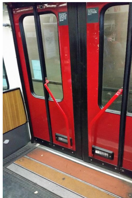
Obrázek 72: Dvoukřídlé zalamovací dveře v městském kolejovém vozidle. Dveře zbytečně zužují světlou šířku pro výstup cestujících a prostor uvnitř vozidla. Pod červenou podlahou se skrývají schody, které se vykloupí v případě zastavení u nízkého nástupiště
