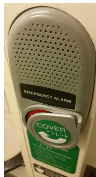
Obrázek 115: Tlačítko nouze je ve stísněném prostoru toalety překryto klapkou, aby nedocházelo k nechtěnému stisknutí.
