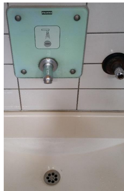
Obrázek 111: Kontaktní ovládání pomocí dotykové desky. Toto řešení se sice dobře čistí, ale není vhodné, jelikož člověk nemá indikaci, jestli ho senzor zaregistroval a co má udělat pro to, aby byl registrován – jestli stačí desce přiblížit ruku, stačí se dotknout, nebo musí dokonce tláčit.
