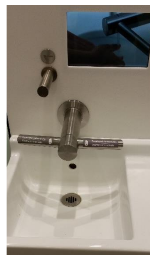
Obrázek 126: Vysokorychlostní sušák je zabudován přímo v kohoutku na vodu a voda z rukou tedy při sušení kape přímo do umyvadla.
