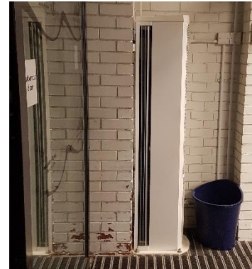
Obrázek 136: Tepelná závora u vstupu do budovy.
