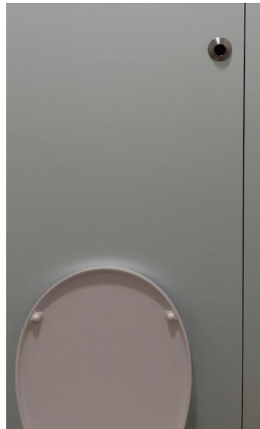
Obrázek 114: Splachování toalety je ovládáno přiblížením ruky před bezkontaktním senzorem na stěně. Takovéto ovládání je hygienické a na toaletu vhodné. Pokud už ale výrobce vybaví splachování bezdotykovým senzorem, bylo by dobré mít i zbytek ovládání (dveře, umyvadlo, ...) bezkontaktní.
