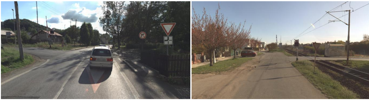
Obr. 18: Příklad opět špatně provedeného opatření z hlediska psychologické přednosti (P2609 - Česká Kamenice – vlevo a P4001 - Hradec Králové – vpravo)
