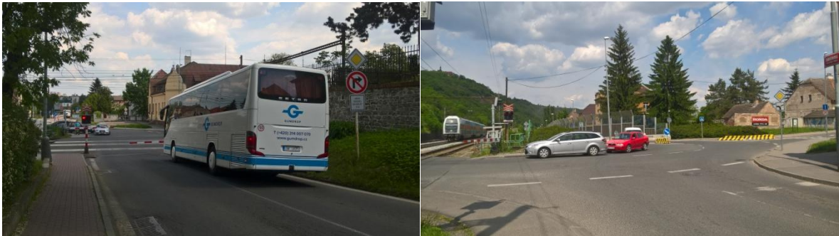
Obr. 19 : Záměna hlavní a vedlejší komunikace na přejezdu umístěném na hlavní komunikaci (P0261 – Praha – ulice Radotínská a Starochuchelská)
