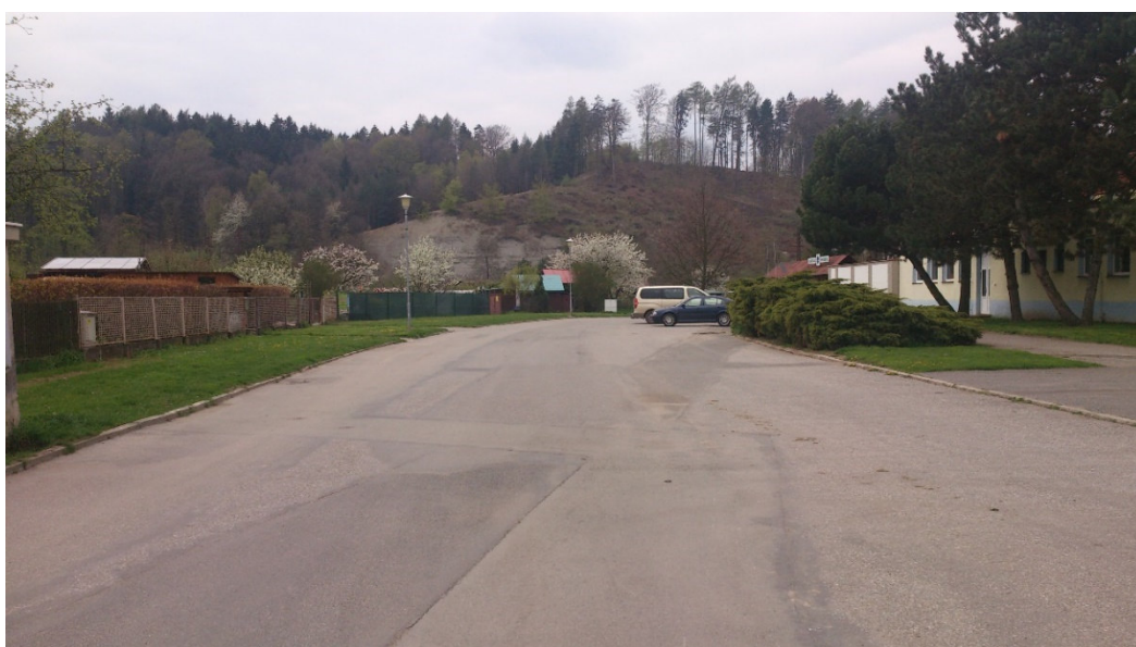
Obrázek 30- Současný stav řešení parkovacích míst před zimním stadionem
