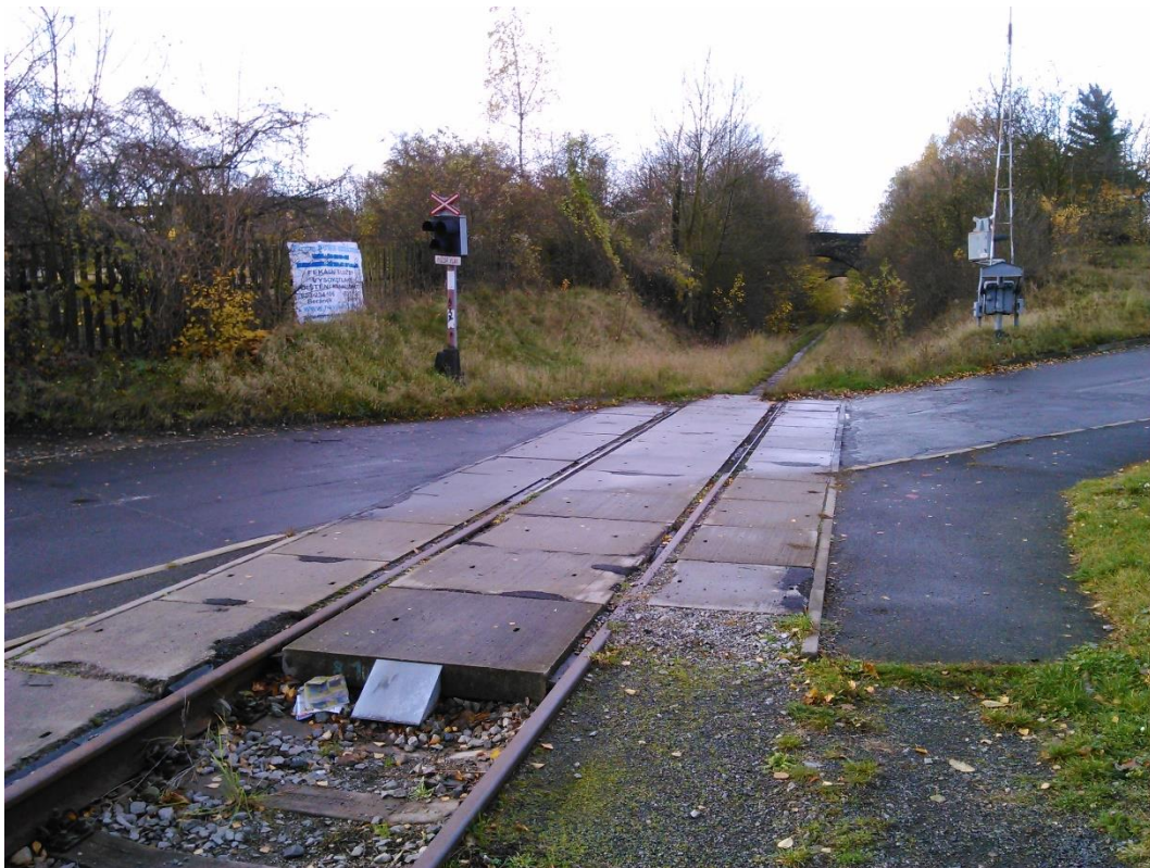
Foto 22 - Zachovaný železniční přejezd P2041 přes komunikaci II/253 určený k rekonstrukci
