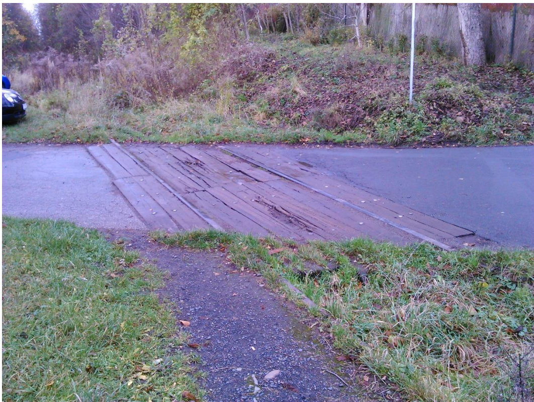
Foto 20 - Zachovaný železniční přejezd P2037 vedoucí k lanové dráze určený k rekonstrukci
