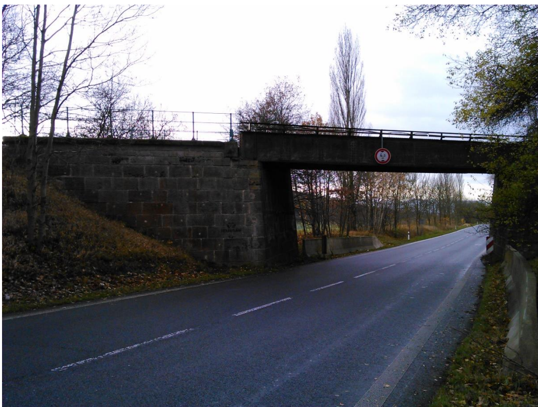
Foto 16 - Mostní objekt přes silnici I/13
