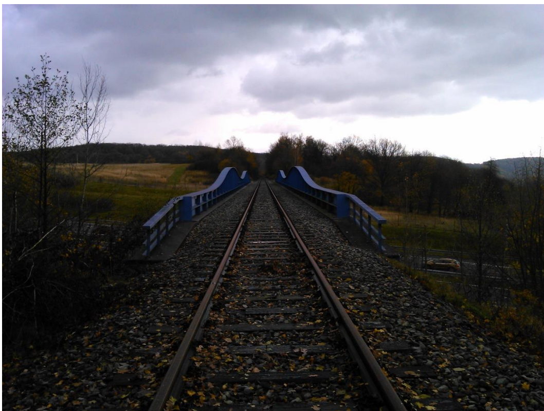
Foto 13 - Železniční most v km 19,459 ocelové konstrukce nad dálnicí D8
