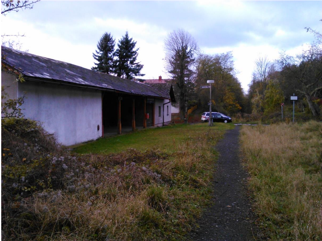
Foto 19 - Zastávka Bohosudov se sypaným nástupištěm
