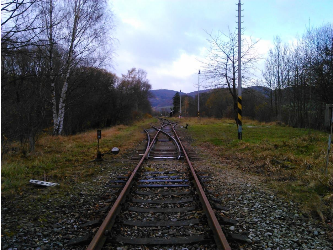
Foto 9 - Pohled na Děčínské zhlaví v dopravně Libouchec
