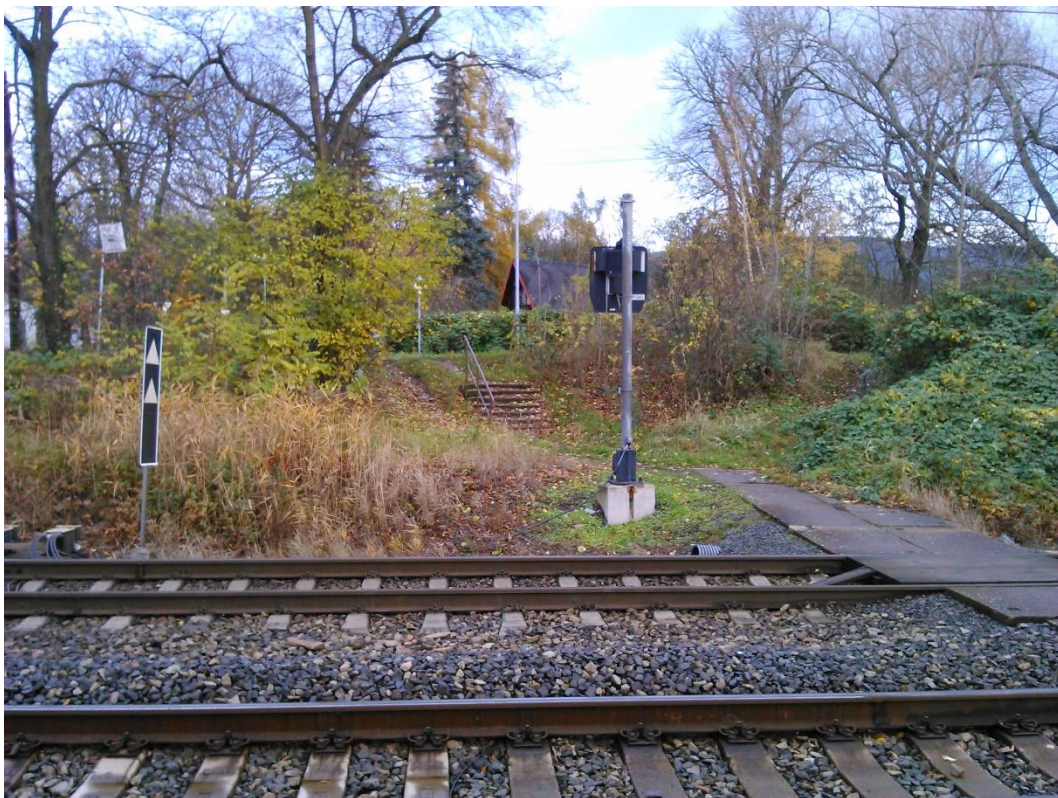
Foto 24 - Železniční přechod pro chodce na trati 130
