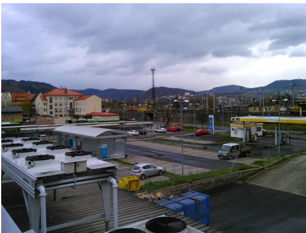
Foto 4 - Prostor vedení mostního objektu dl. 257 m v oblasti autobusového nádraží a parkoviště
