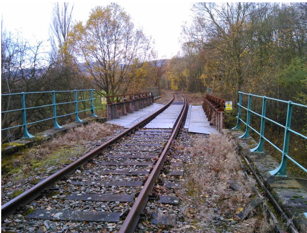
Foto 15 - Mostní objekt přes silnici I/13
