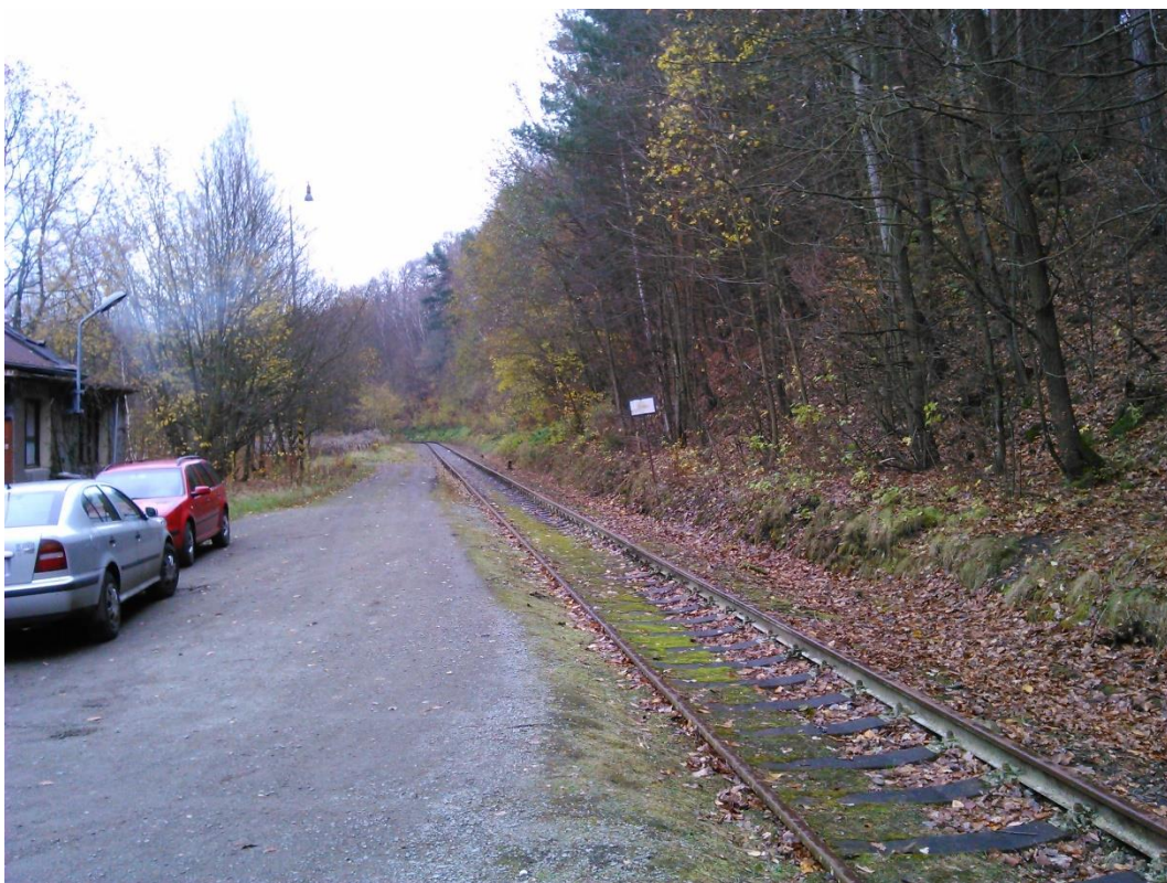
Foto 7 - Zastávka Děčín – Bynov se sypaným nástupištěm
