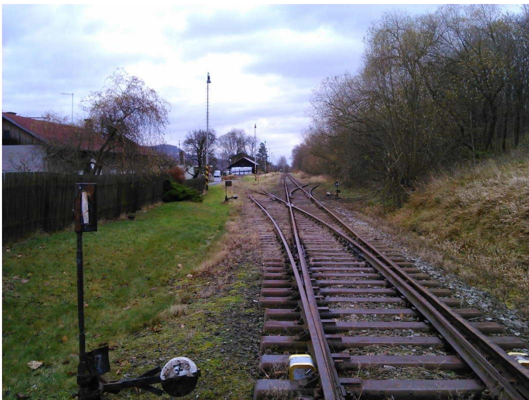
Foto 11 - Pohled na Oldřichovské zhlaví v dopravně Libouchec
