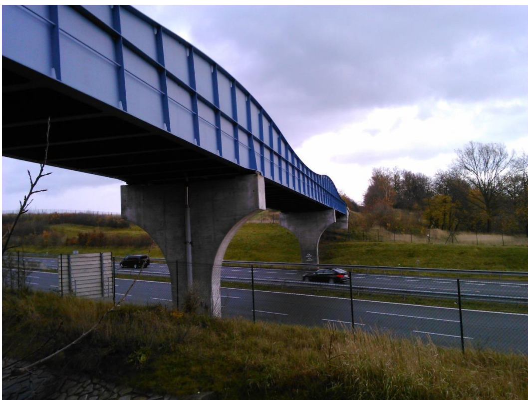
Foto 14 - Železniční most v km 19,459 ocelové konstrukce nad dálnicí D8
