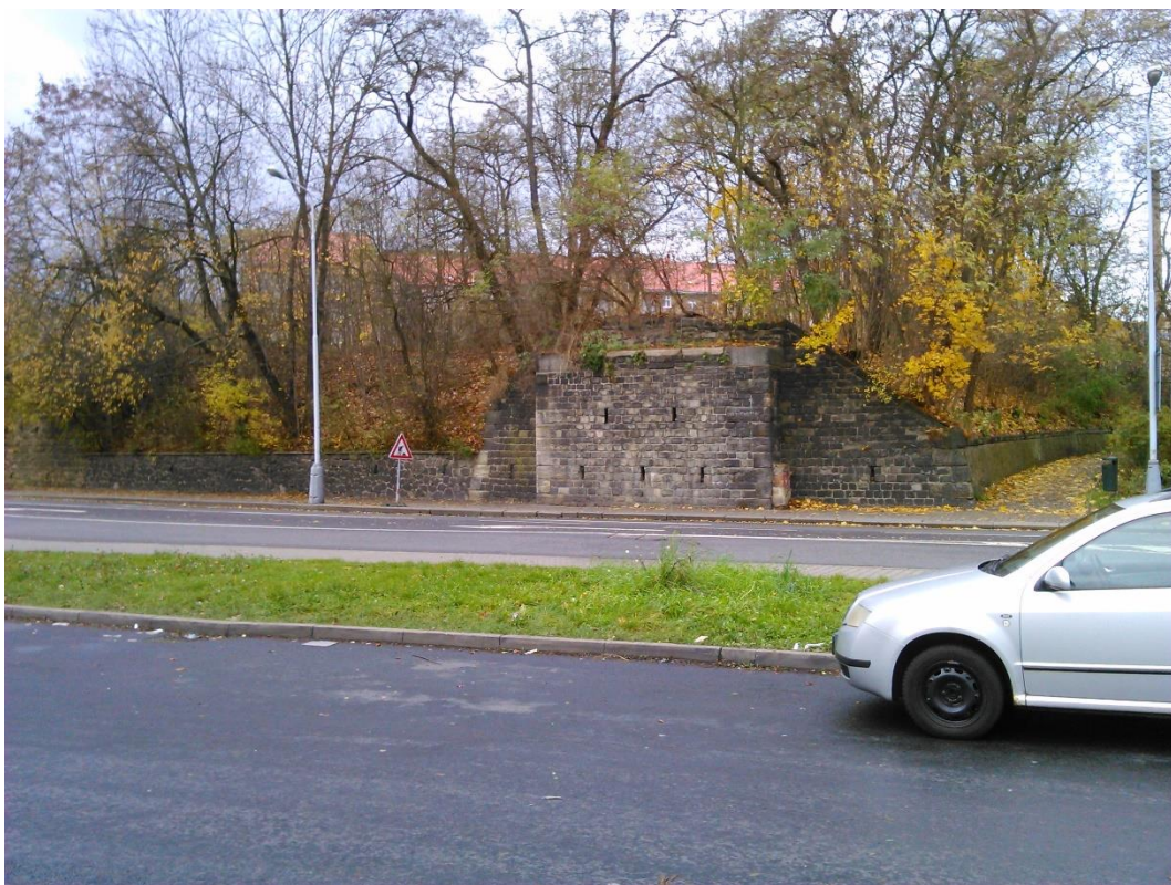
Foto 5 - Původní těleso železničního spodku pro připojení mostního objektu dl. 257 m
