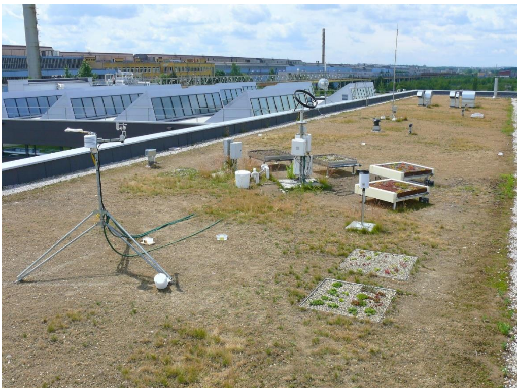
Obr. 2: Pohled na zelenou střechu experimentálního centra UCEEB v den evaporačního experimentu dne 25. června 2015. V levém horním rohu pohled na část střechy pokryté betonovými dlaždicemi se světlíky.
