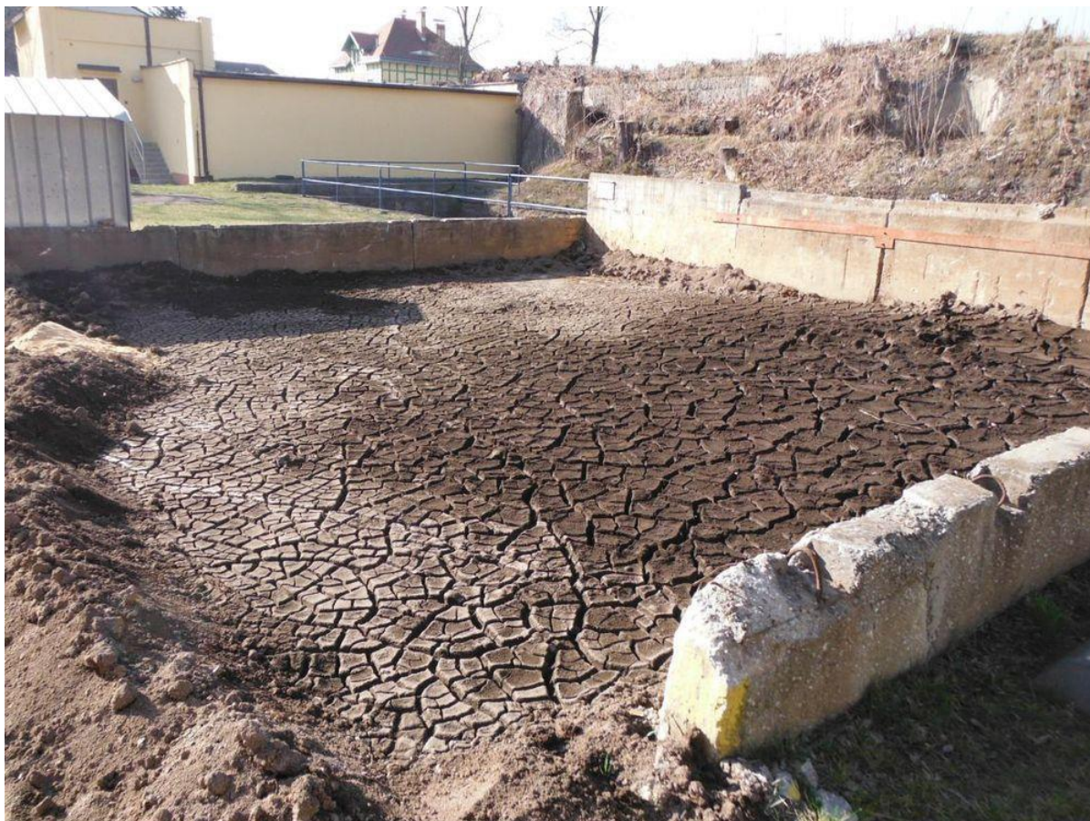
Obrázek 12: Kalové pole voda.tzb-info.cz
