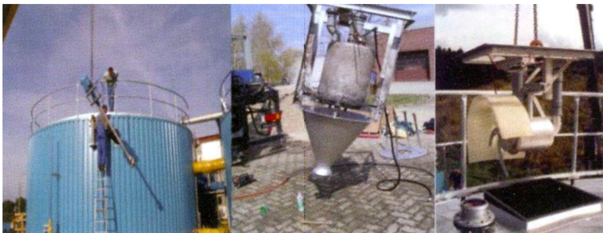
Obrázek 3:Boční provzdušňovač, centrální provzdušňovač, řezač pěny hgf10.vsb.cz
