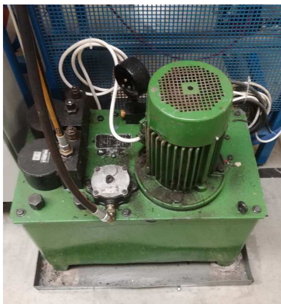
Obr 3.8. Ochrana pracovního prostředí
