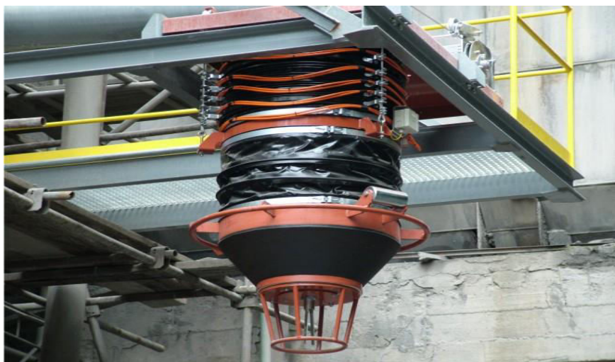
Obr.6: Teleskopický rukáv pro plnění přepravníku, převzato z [2]
