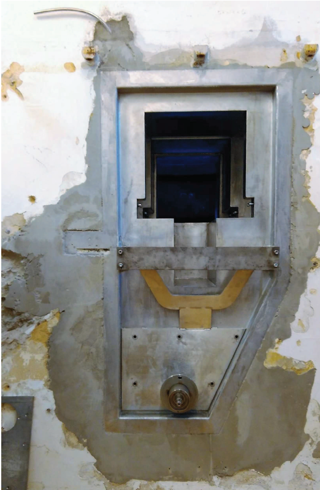
Obr. 52: Pohled na průzor z ovladovny
