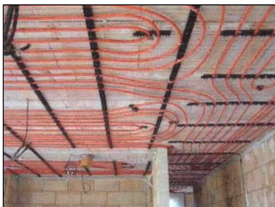
Obr. 2-12 Realizace stropního chlazení s potrubním systémem [14]
