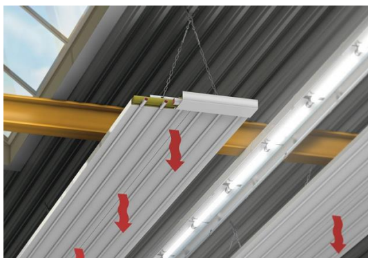
Obr. 2-7 Závěsné sálavé panely v prostorách výrobní haly [21]
