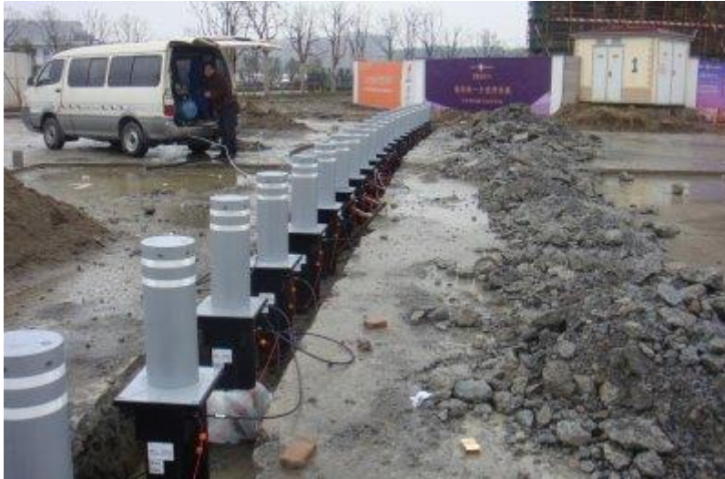
Obr. 11- Montáž výsuvných sloupků
