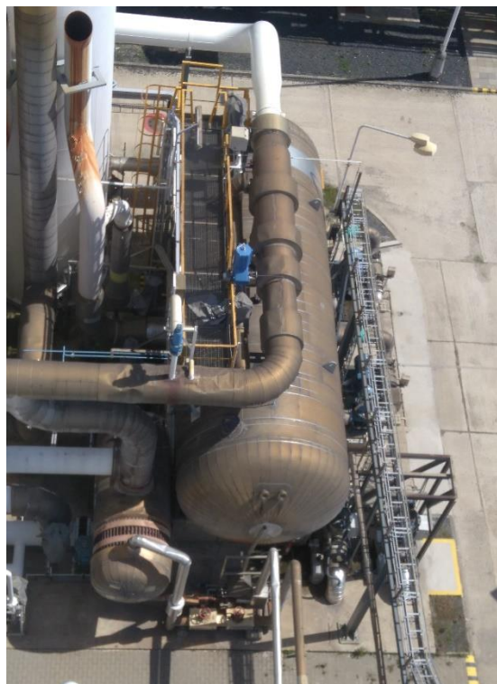
Obr. 12: Ležatá nádoba-TSA molekulové síť Zdroj: Vlastní
