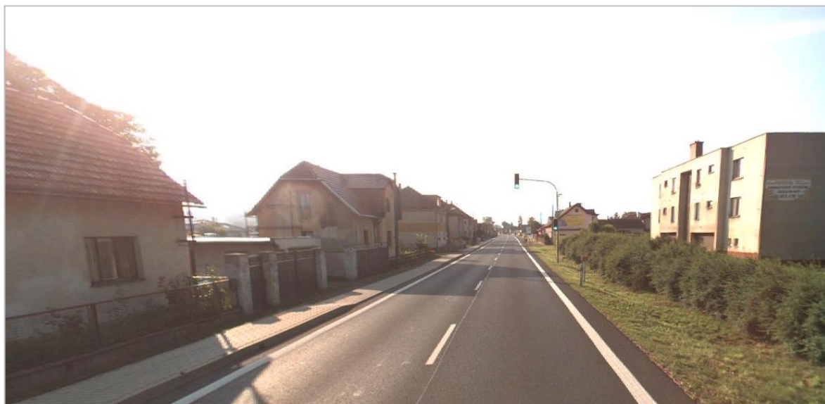
Obrázek 9 – silnice I/16 - zpomalovací SSZ, pohled ve směru jízdy na Mladou Boleslav [4]
