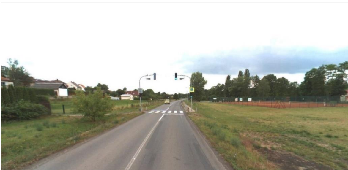
Obrázek 14 – Hoštka – silnice II/261 – zpomalovací SSZ, směr Štětí [6]
