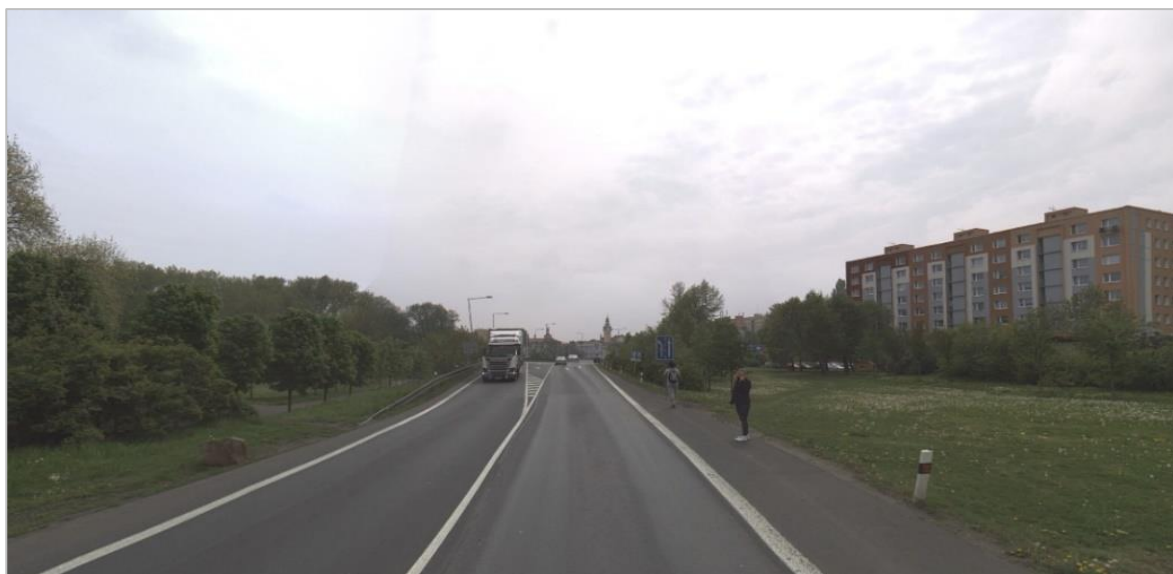
Obrázek 23 – Lovosice – pohled na řešené místo směrem do centra města [9]
