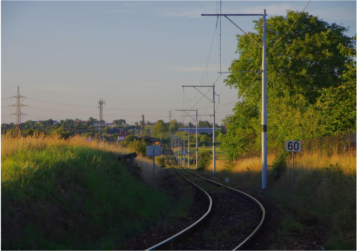
Obrázek 15: Pohled od přejezdu v Čenkově u Malšic směrem na Malšice
