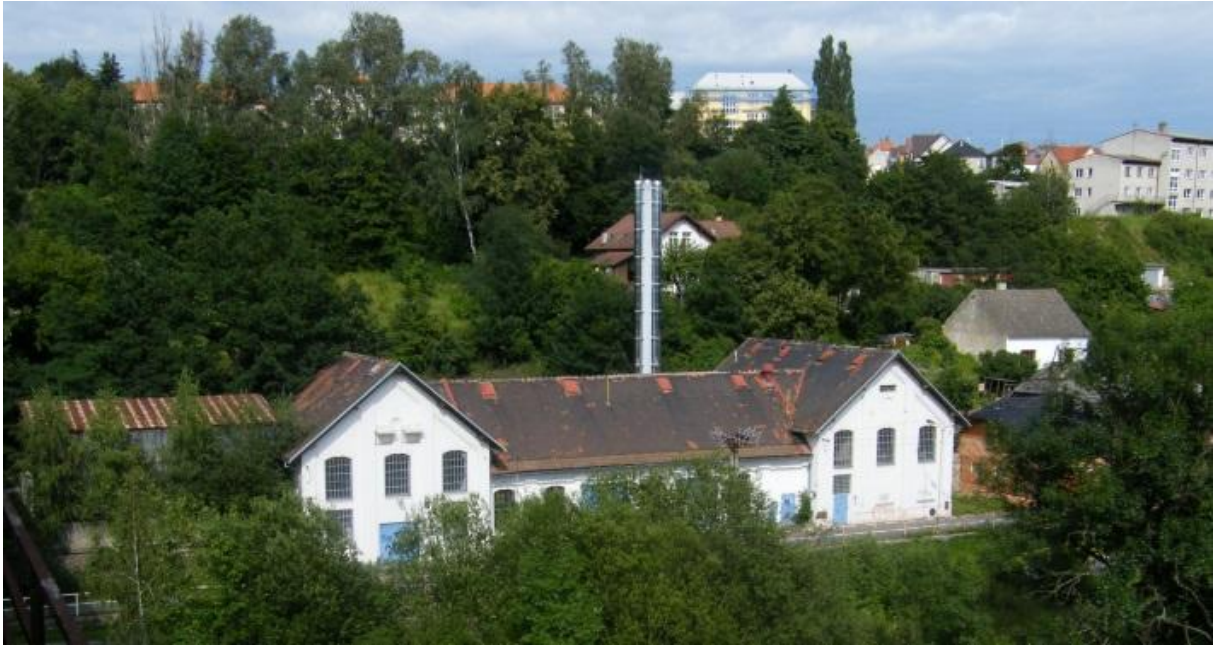
Obrázek 5: Elektrárna Tábor, z níž se trať původně napájela
