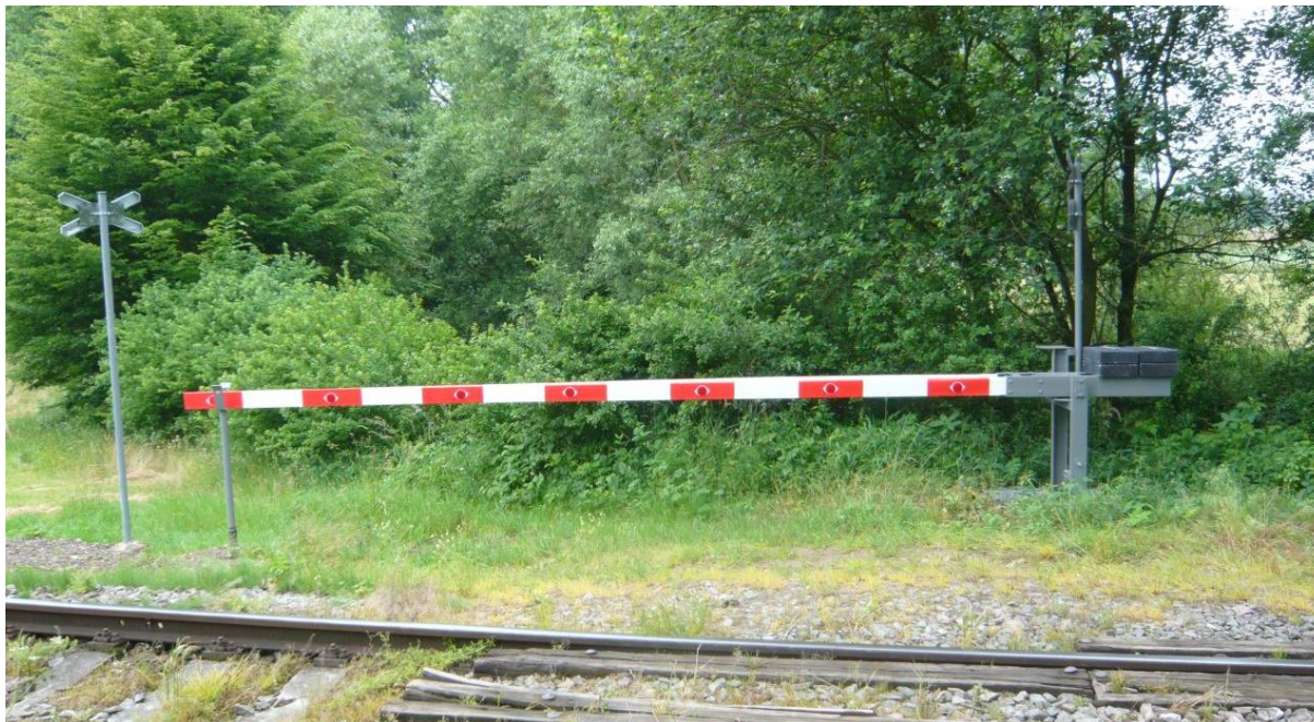
Obrázek 19: Mechanická závora pro místní obsluhu [13]
