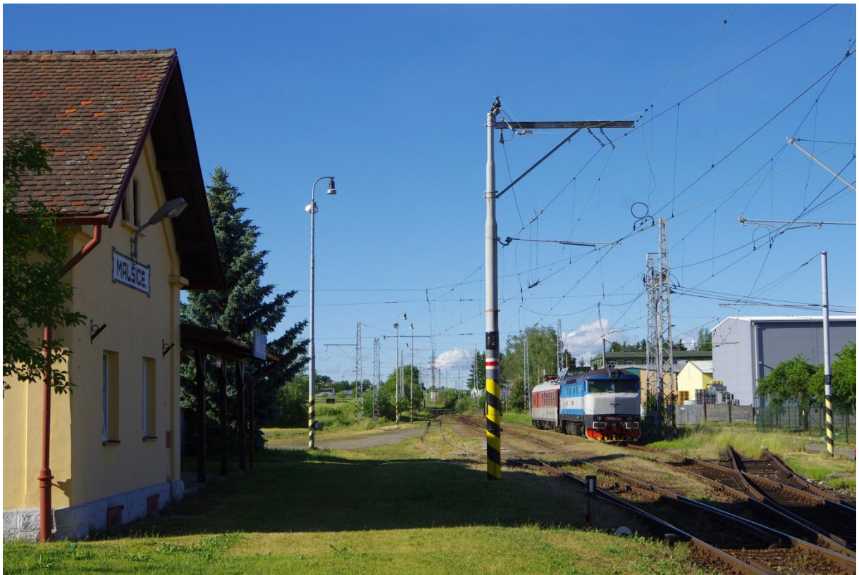
Obrázek 14: Lokomotiva 749.259-8, která měla povolenou mimořádnou přechodnost, veze měřicí vůz pevných trakčních zařízení a čeká na křižování v dopravně Malšice v červnu 2017
