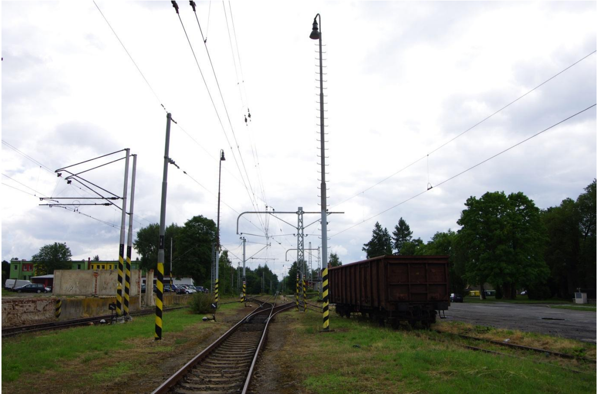
Obrázek 29: Pohled od remízy na kolejové rozvětvení směrem ke stanici
