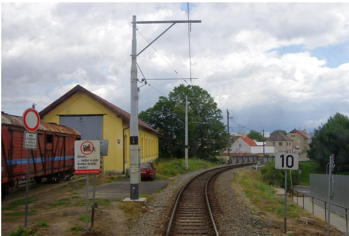
Obrázek 3: Oblouk o poloměru 125 m bez převýšení, v pozadí jeden z tzv. tábořských Černých mostů, vlevo původní remíza elektrické dráhy na místním nádraží v Táboře
