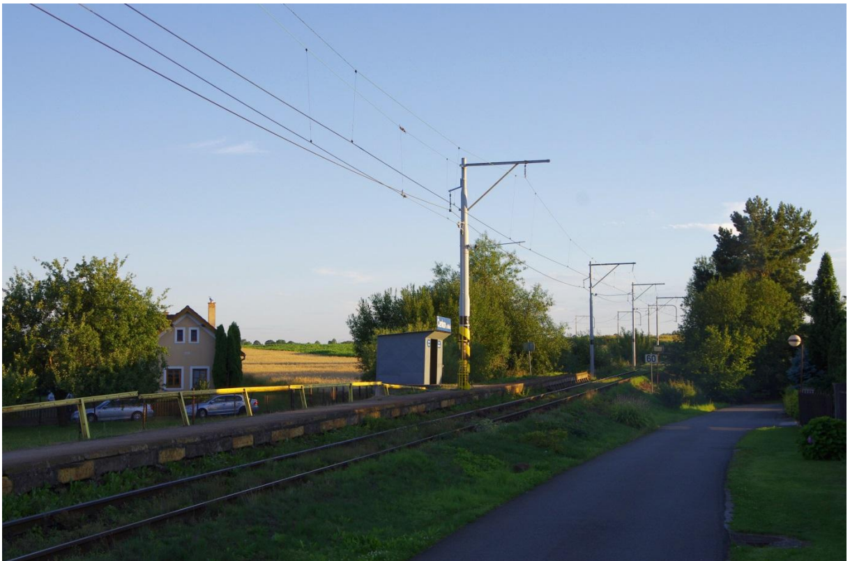
Obrázek 16: Zastávka Čenkov u Malšic, pohled ve směru do Bechyně
