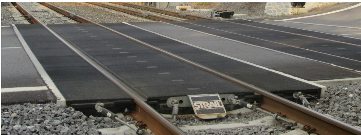
Obrázek 20: Celopryžová konstrukce železničního přejezdu
