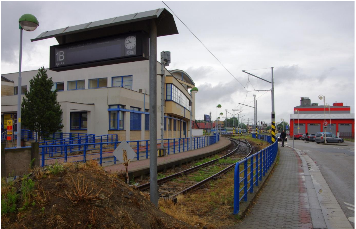
Obrázek 1: Pohled na nástupiště B v Táboře a zároveň km 0,0 tratě Tábor - Bechyně
