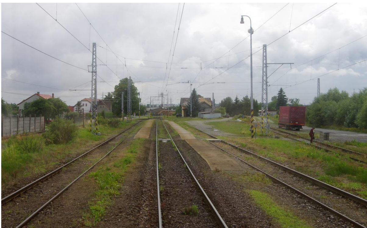
Obrázek 12: Nástupiště v dopravně Malšice, vpravo kusá kolej s rampou čelní a boční
