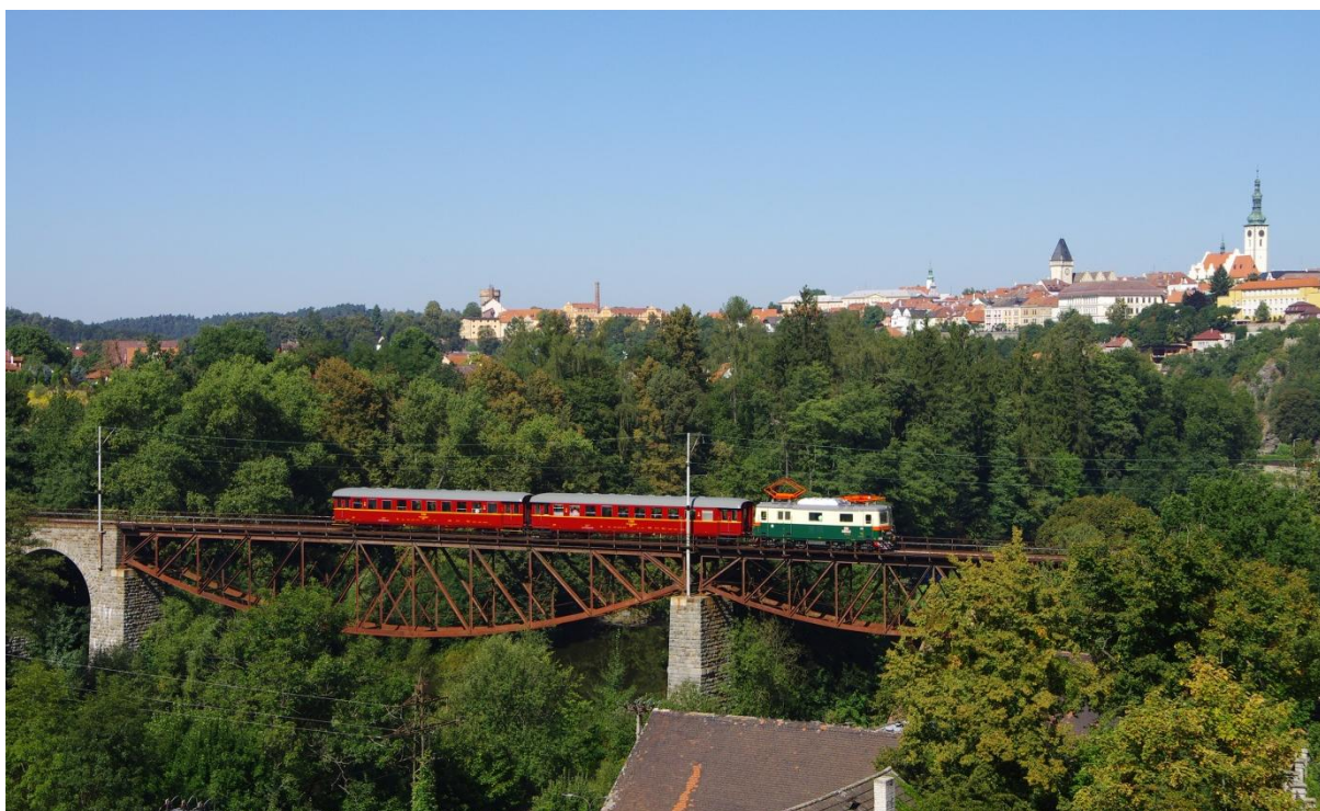
Obrázek 4: Most přes Lužnici v Táboře s vlakem Os 28409 vedeným lokomotivou E422.0003
