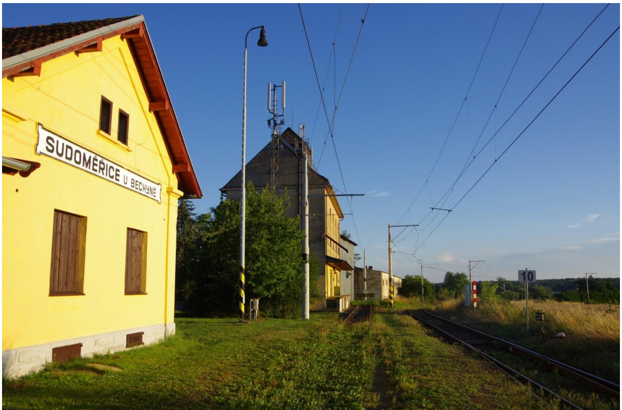
Obrázek 22: Dopravna Sudoměřice u Bechyně, vpravo oblouk o poloměru 125 m bez převýšení
