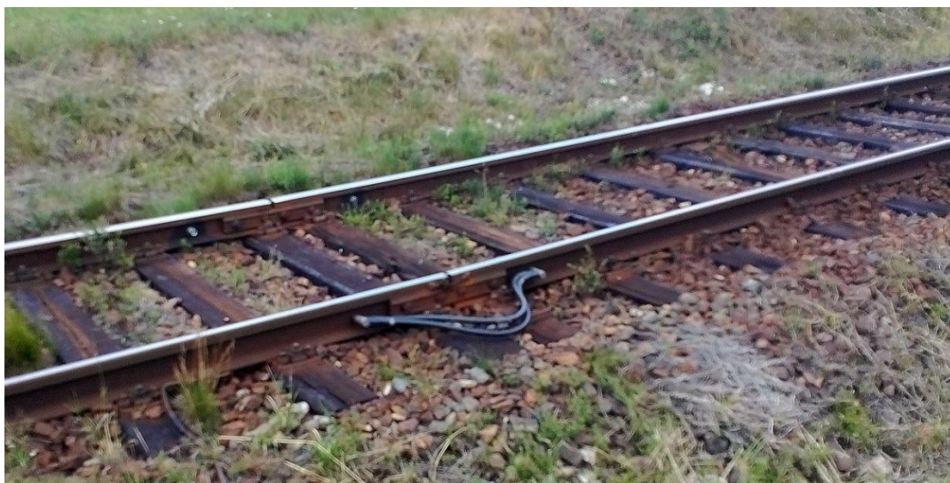
Obrázek 4: Železniční svršek, pohled na kolejnicový styk
