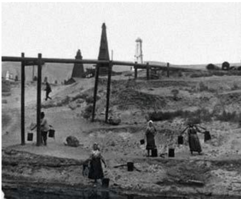
Obrázek 3.: První potrubní přepravní systém na přepravu ropy vytvořený bratry Nobel 15
