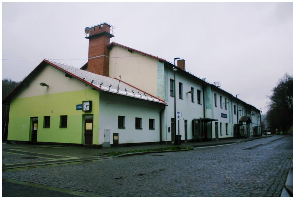
Obr. 44: Pohled na výpravní budovu
