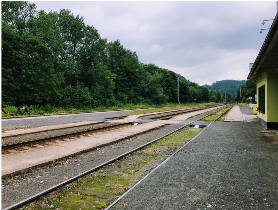
Obr. 43: Pohled na nástupiště
