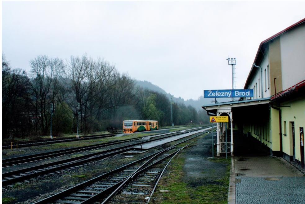
Obr. 42: Pohled na kolejíště
