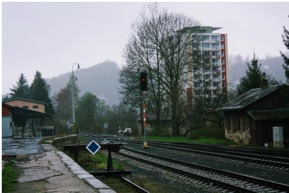
Maloskálské zhlaví a pohled na boční rampu, [7.4.2017]
