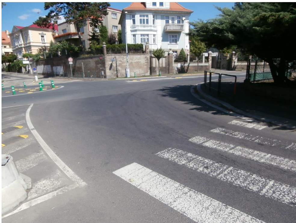
Obrázek 32: Nároží bez srpovité zpevněné krajnice na rameni Nádražní (Zdroj: vlastní foto)
