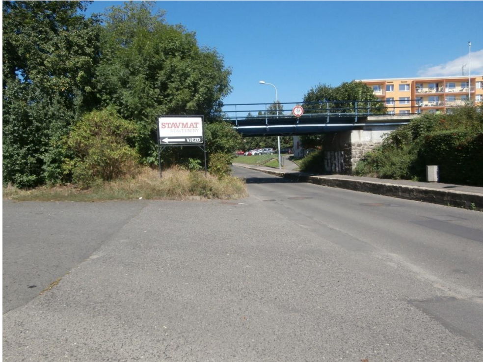
Obrázek 12: Rozhledové poměry z ramene ÚK Stavebniny (Zdroj: vlastní foto)
