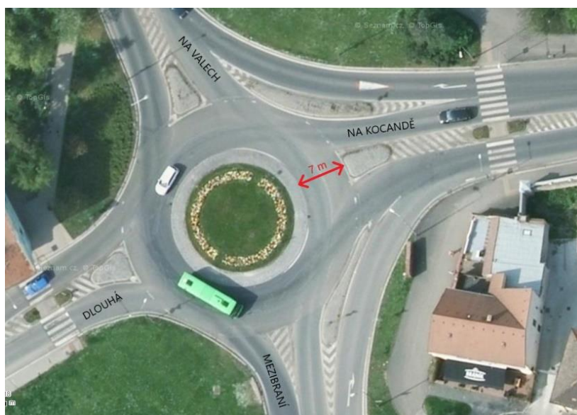
Obrázek 28: Okružní křižovatka Na Kocandě x Mezibraní x Na Valech x Dlouhá s vyznačením šířky okružního pásu
