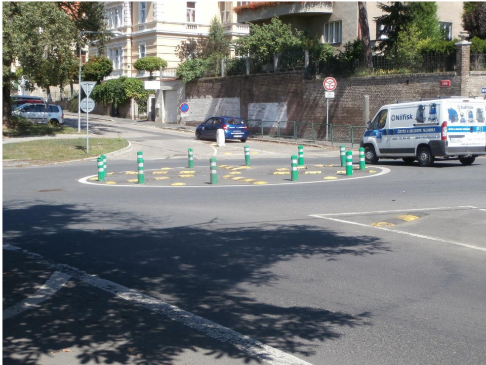
Obrázek 31: Nedostatečné zdůraznění křižovatky provedením středového ostrova (Zdroj: vlastní foto)
