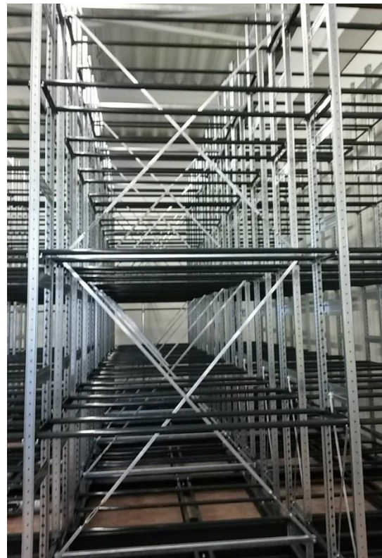
Obr. 20.: Zavětrovací táhla [Autor]
