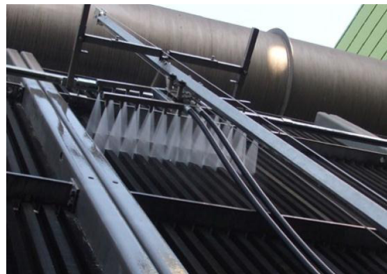
Obr. 2-7: Zařízení na čištění žebrovaných trubek od usazených nečistot a prachu. [9]
