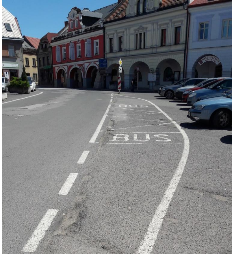
Obrázek 17 - Zastávka směr Jičín/Trutnov na silnici III/28010 (foto autor)
