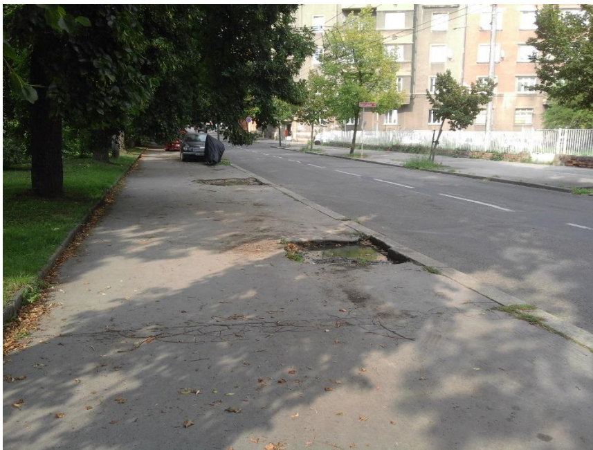
Obrázek 22 Rozbitý chodník (zdroj: vlastní fotografie)
