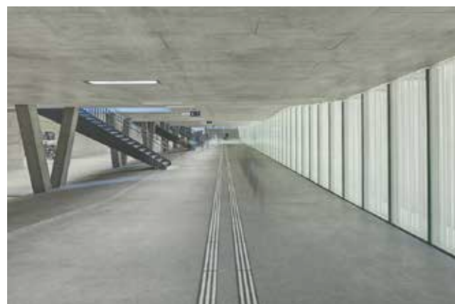
Referenční snímek - Bahnhof Oerlikon Světelná instalace
