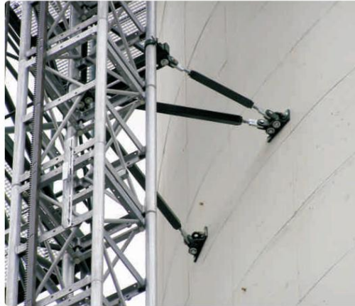
Obr. 2.24.: Kotvení stožáru k objektu. [16]
