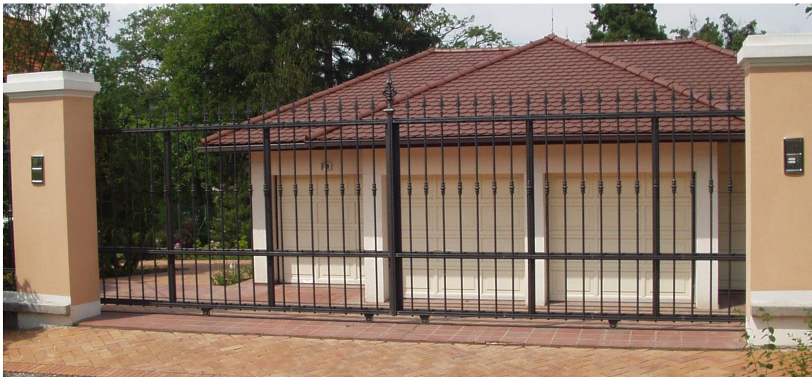
Obr. 6: Protiběžná posuvná vrata [5]
