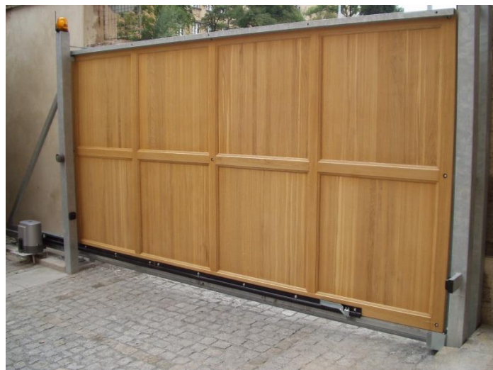
Obr. 4: Samonosná jednokřídlová posuvná vrata [5]
