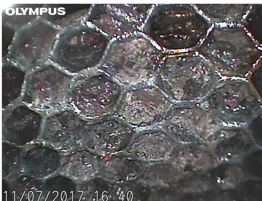
Obrázek 42- Primární přívod do výměníku A po vyčištění
