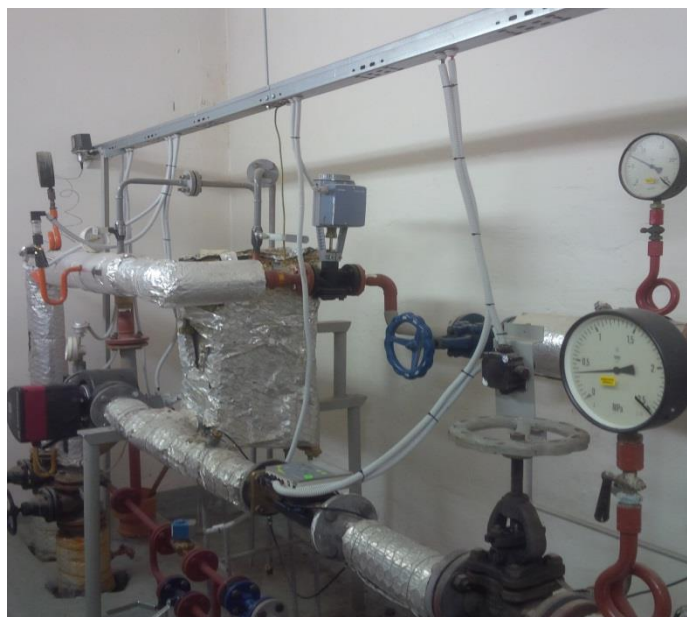
Obrázek 11 – Předávací stanice s jedním modulem -ÚT
