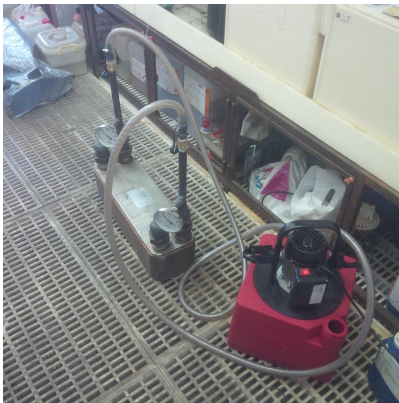
Obrázek 35 – čištění deskového výměníku
