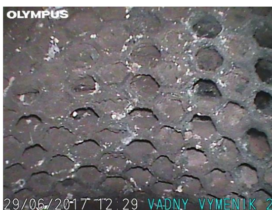
Obrázek 28 – Výstup z primární strany výměníku A
