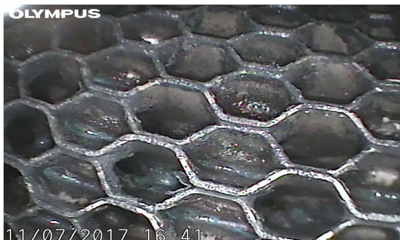
Obrázek 41- výměník A po vyčištění (primární zpátečka)
