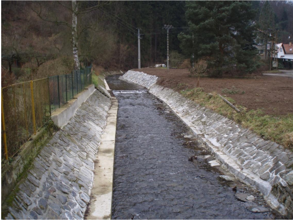
Fotografie 29 – Upravené koryto Bojovského potoka v obci Měchenice
