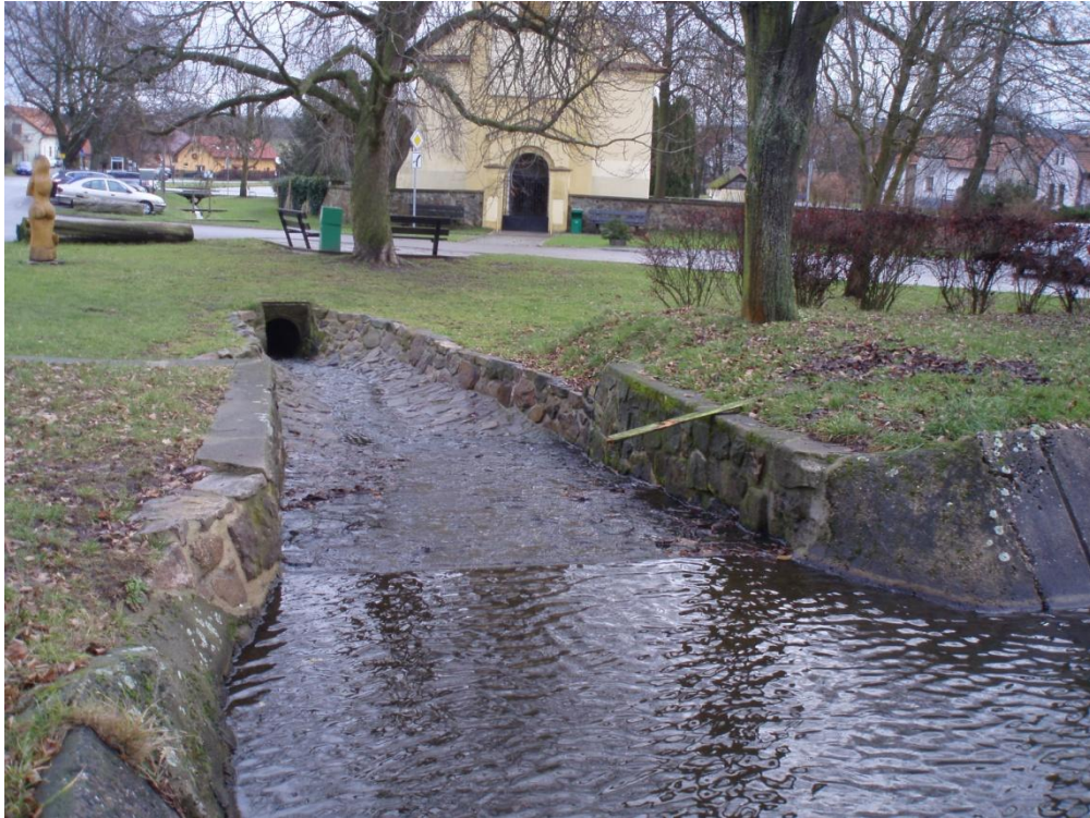
Fotografie 23 – Bezpečnostní přeliv rybníka v obci Kytín
