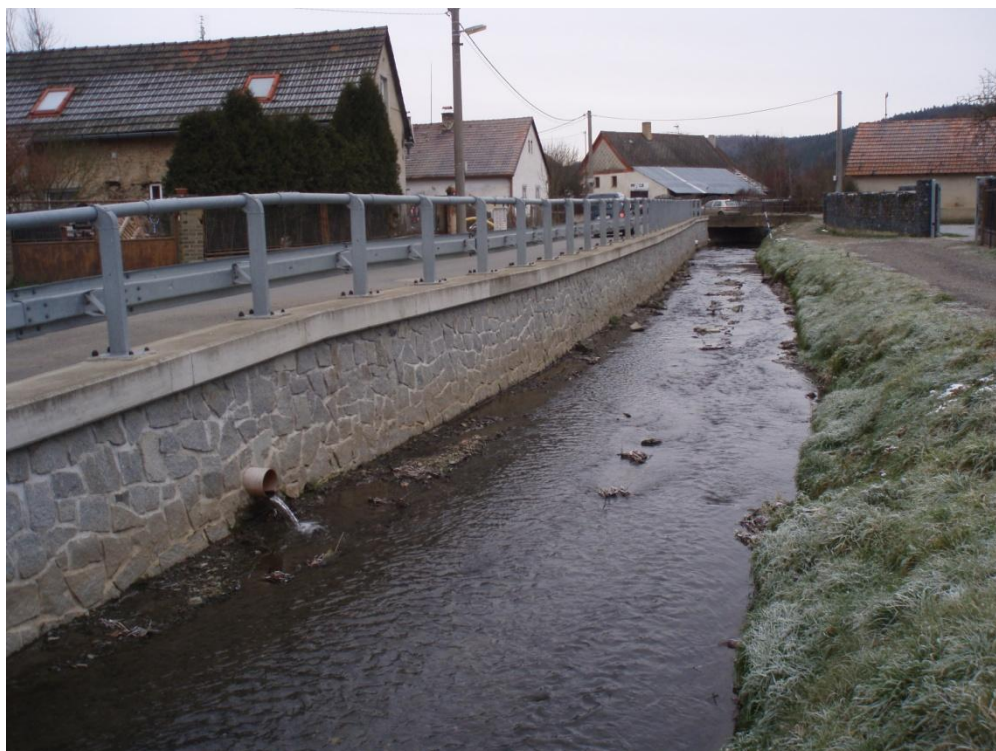
Fotografie 13 – Opravená komunikace po povodni v roce 2013 v obci Čisovice
