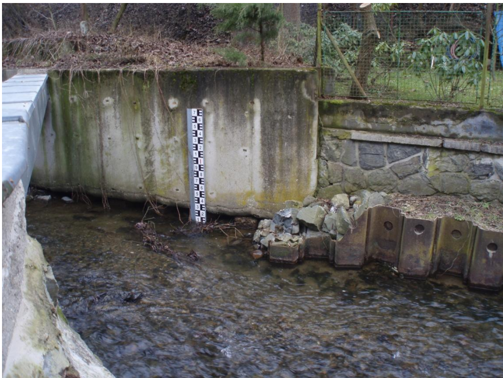
Fotografie 30 – Vodočetná lať na Bojovském potoku v obci Měchenice
