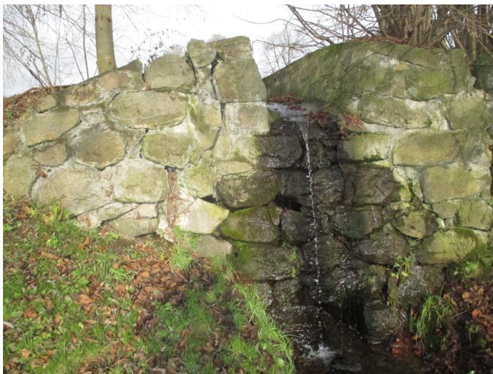
Fotografie 10 – Narušený bezpečnostní přeliv rybníka v obci Buš
