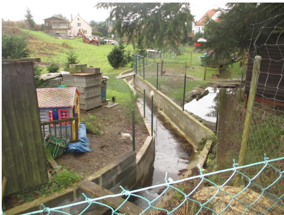
Fotografie 8 – Přemístění vodního toku mimo přirozené koryto v obci Buš
