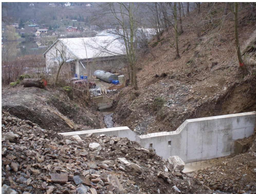
Fotografie 36 – Nově budovaná přehrážka na potoce z obce Trnová
