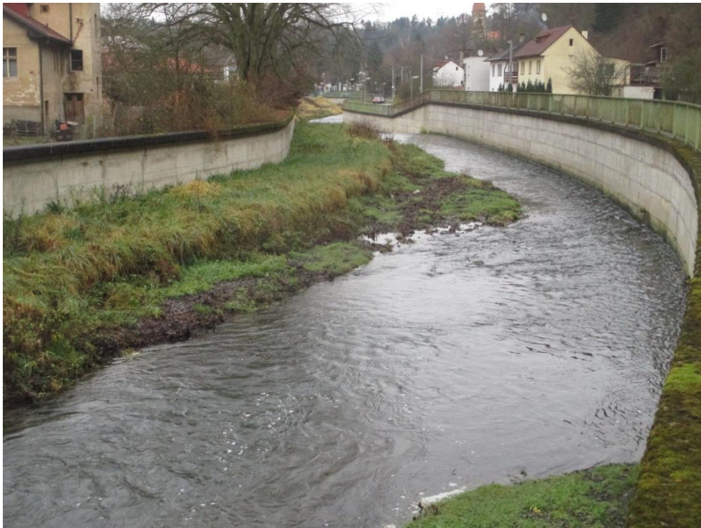
Fotografie 33 – Neodtěžená naplavenina z koryta říčky Kocáby v obci Štěchovice
