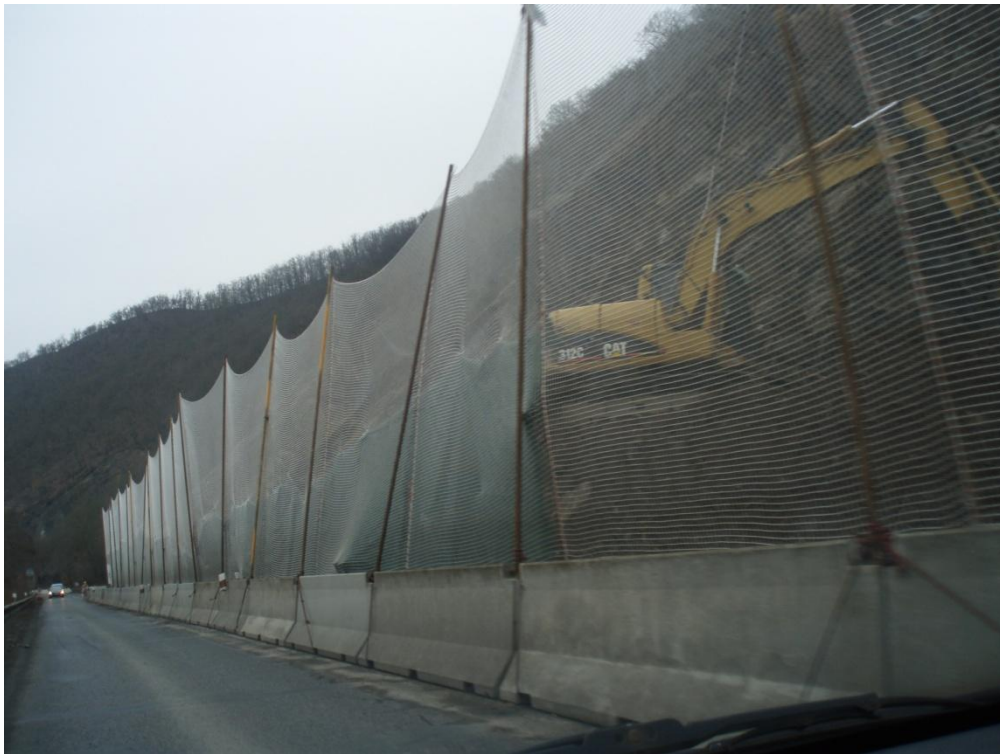
Fotografie 21 – Zajišťování skalních bloků, silnice II. třídy číslo 102, mezi Prahou a obcí Měchenice
