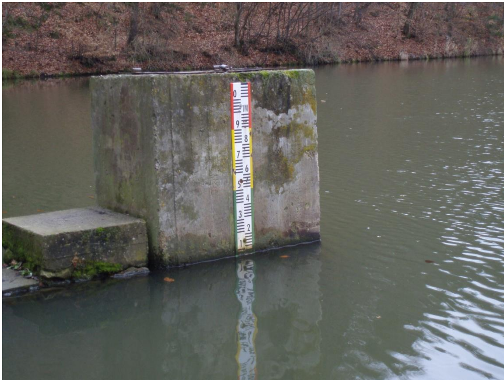
Fotografie 31 – Vodočetná lať na Prostředním rybníku v Mníšku pod Brdy
